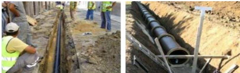
Figura 2.8 - Exemplo de abertura em parede vertical e com taludes (Almeida e Cardoso, 2010)
