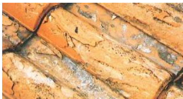
Figura 2.3.3: Exemplo do aspeto da telha sujeita a ciclos de gelo e degelo. [2]
