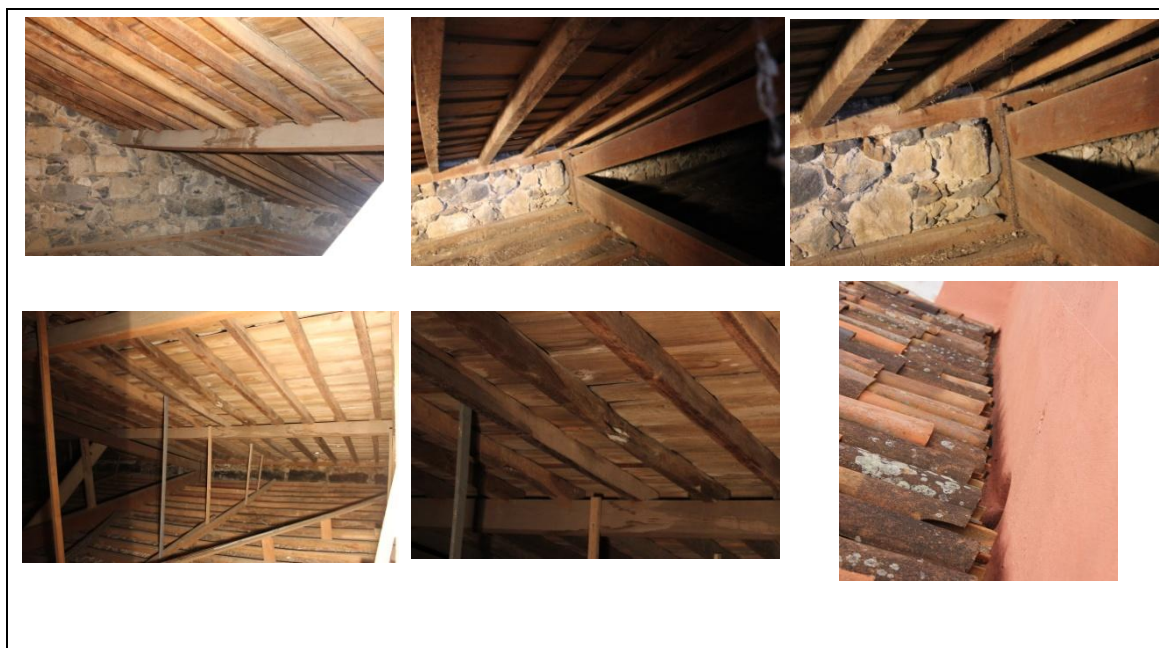
Figura 4.3.1. Imagens de uma cobertura para reabilitação - Caso 2.
