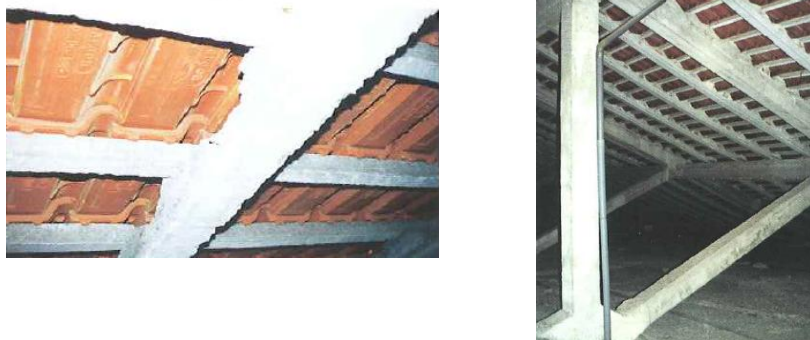
Figura 2.2.5: Exemplo de aplicação de ripado pré-esforçado à esquerda e asna em betão armado à direita. [2]
