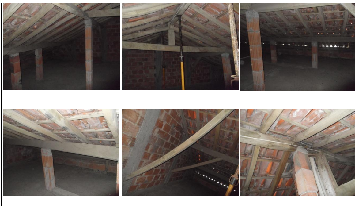
Figura 4.2.1. Imagens de uma cobertura para reabilitação - Caso 1.
