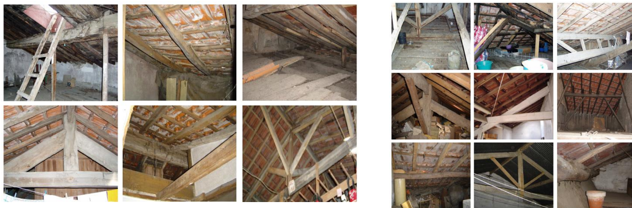
Figura 2.2.8: Exemplos de coberturas observadas na Baixa de Coimbra. [1]
