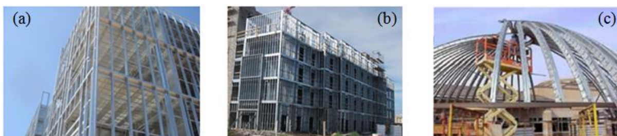
Figura 2.3 - (a) e (b) Edifícios em aço enformado a frio (@Steel Framing Alliance) (c) Cobertura em aço enformado a frio (Silvestre e Camotim 2006)
