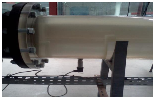
Figura 3.6 – Transdutor de pressão situado na conduta.
