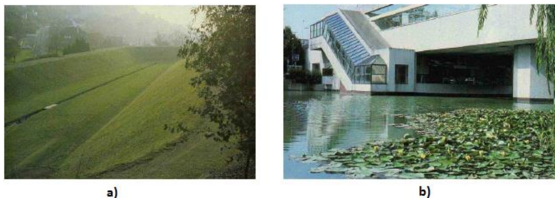
Figura 2.23 – Exemplos de bacias de retenção: a) Bacia seca do Chemim de Clères, França; b) Bacia com água permanente de Marne-la-Vallée, França. (Matias, 2006).
