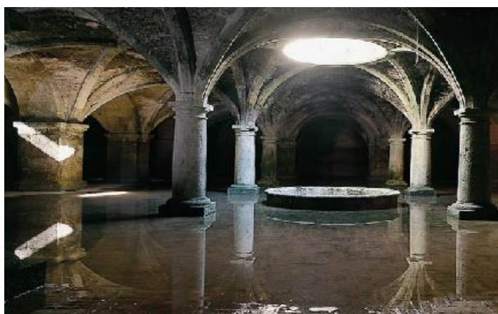
Figura 2.24 – Exemplo de bacia enterrada: Cisterna de Magazão (I.G.P.A.A., 2004).
