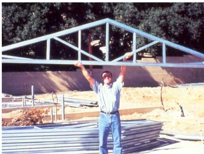
Figura 2.1- Facilidade e rapidez de montagem resultante do peso próprio reduzido (Veríssimo, 2008).
