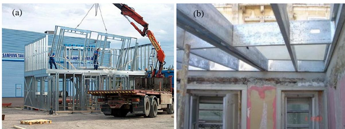
Figura 1.1- Utilizações de perfis de aço enformado a frio (a) na pré-fabricação e (b) na reabilitação de estruturas (Silvestre & Camotim, 2006).
