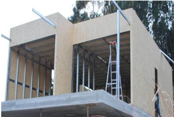
a) Revestimento estrutural com painéis de OSB
