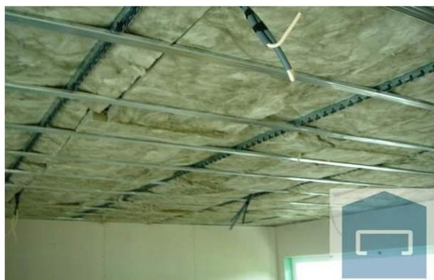
Figura 4.15 – Isolamento acústico/térmico com lã de rocha num teto (Futureng, 2013)
