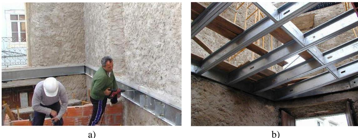
Figura 5.9 – a) Fixação de canal de aço; b) colocação de vigas sobre o canal de bordadura (Silvestre *et al.*, 2013)
