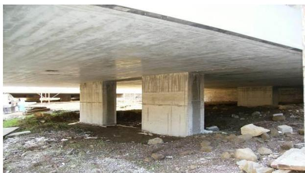
a) Adaptação da fundação da estrutura ao relevo do terreno
