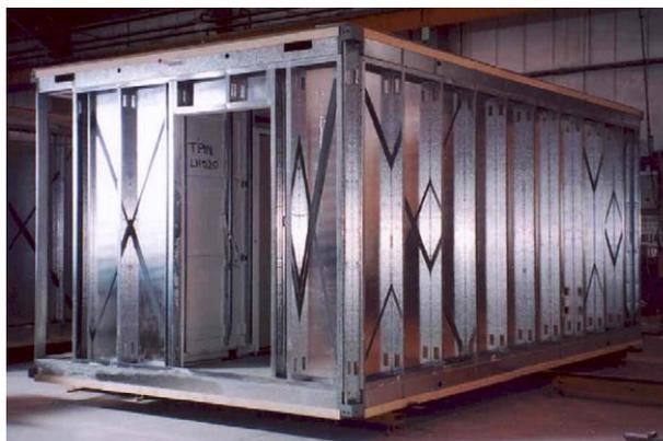
Figura 3.3 – Estrutura para construção modular em aço “leve” (Lawson e Ogden, 2008)
