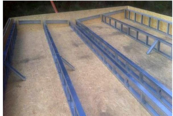
b) Revestimento estrutural da cobertura com painéis de OSB
