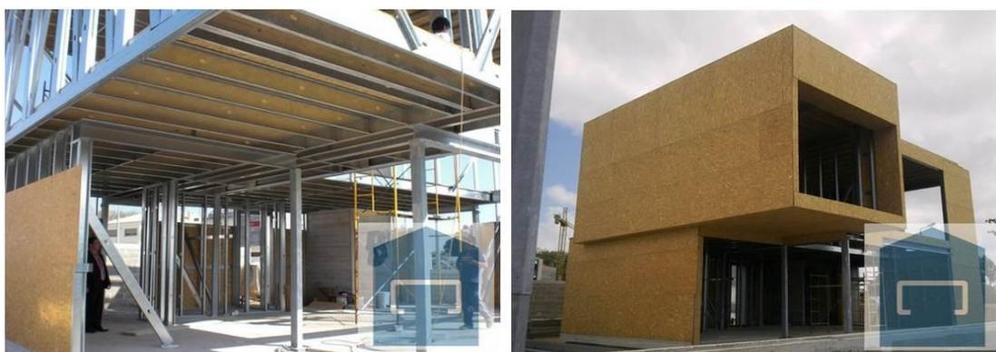
Figura 4.13 – Revestimento estrutural de moradia com recurso a painéis de OSB (Futureng, 2013)
