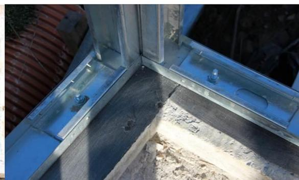
b) Fixação da estrutura metálica à laje, com varão roscado
