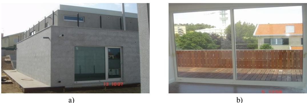
Figura 4.14 – Acabamentos exteriores com recurso a: a) pedras de granito; b) decks de madeira (Silvestre *et al.*, 2013)
