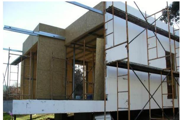
d) Revestimento exterior com poliestireno expandido, ETICS
