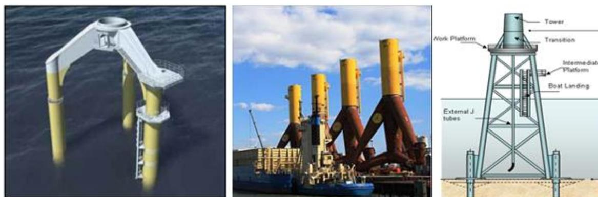
Figura 1.3- Fundação tripile, tripod e jacket, respectivamente.
