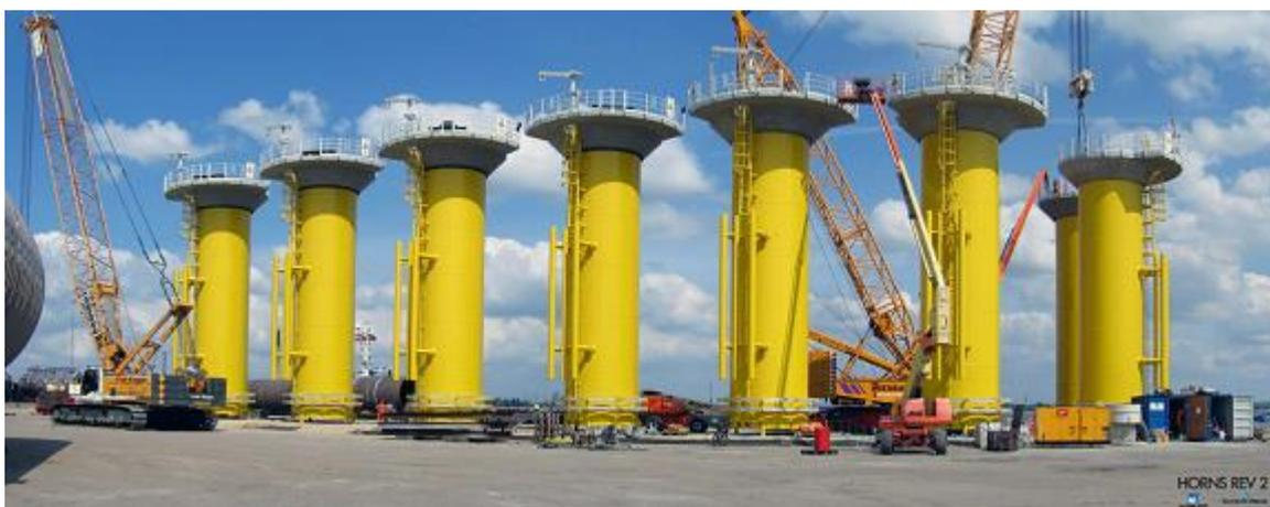
Figura 2.2- Fundação monopile (Rebello e Simões da Silva, 2009)
