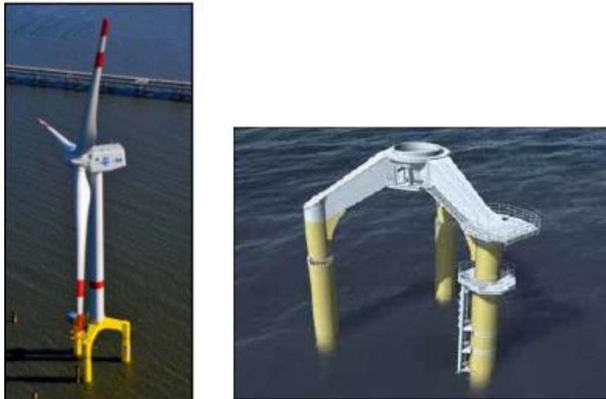
Figura 2.4- Fundação tripile (ASW, 2009).
