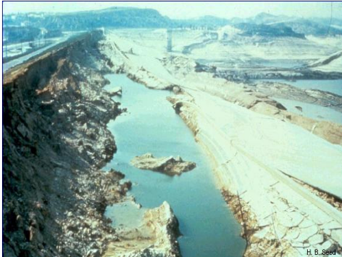
Figura 5 – Barragem San Fernando após o sismo de 1971
