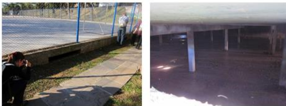
Figura 2.21 – Bacia de retenção subterrânea em Porto Alegre, Brasil (cortesia de Simões, N.)
