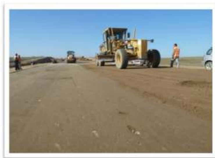
Figura 3.8 – Regularização e compactação da mistura
