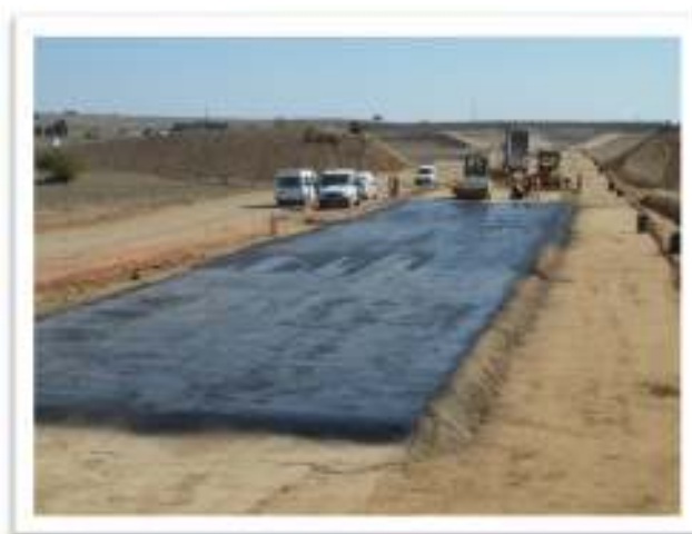
Figura 3.3 – Trecho experimental em solo-cimento
