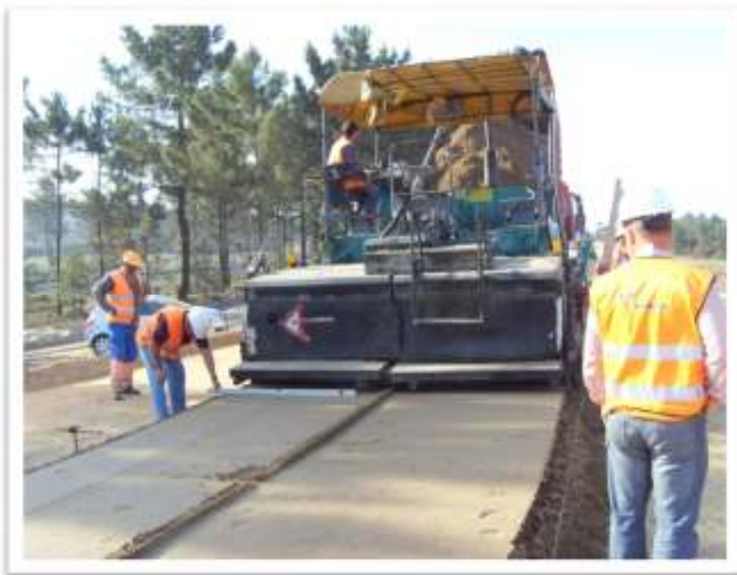
Figura 3.10 – Espalhamento com recurso a espalhadora
