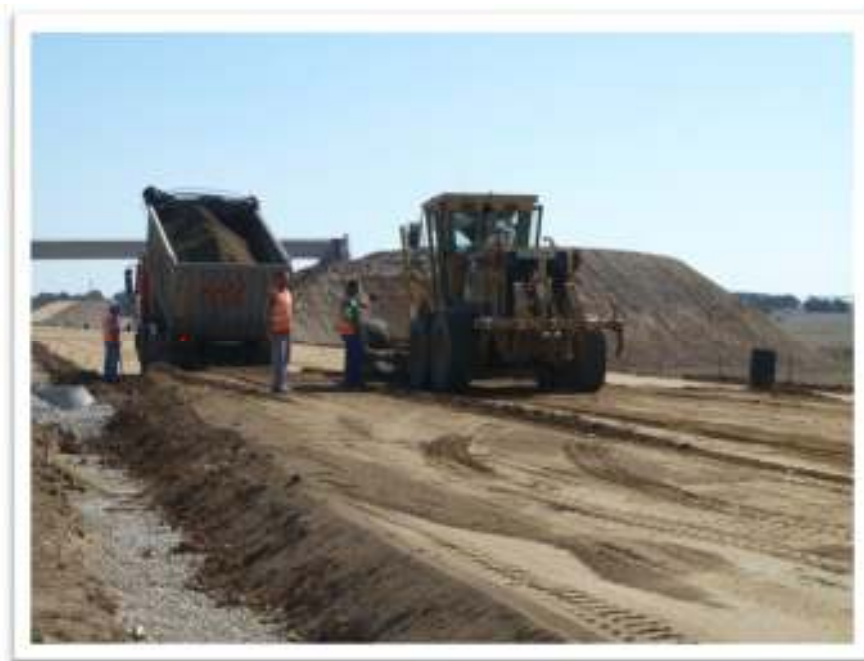
Figura 3.7 – Espalhamento dos solos
