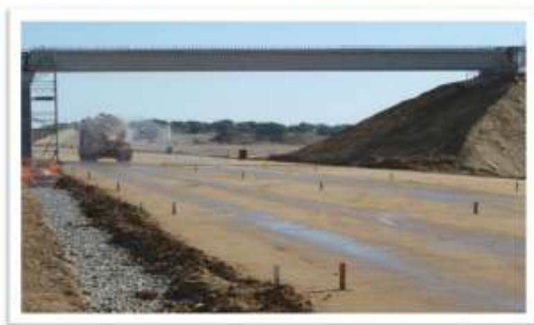
Figura 3.6 – Preparação da PSA
