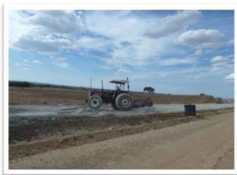
Figura 3.13 – Mistura solo-cimento com grade de discos
