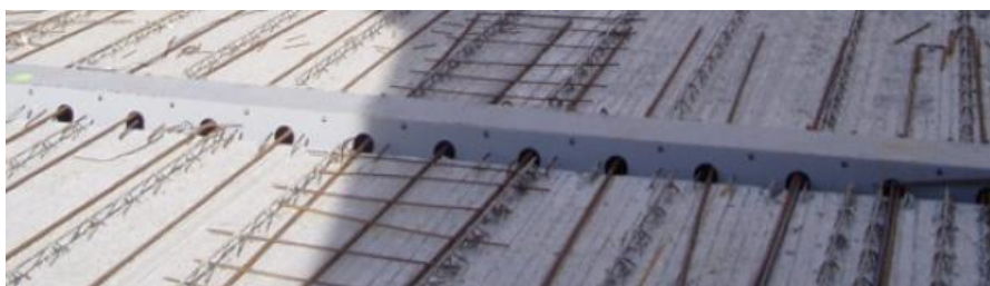
Figura 2.9 - Armaduras que atravessam a Deltabeam (Hauf, 1996).
