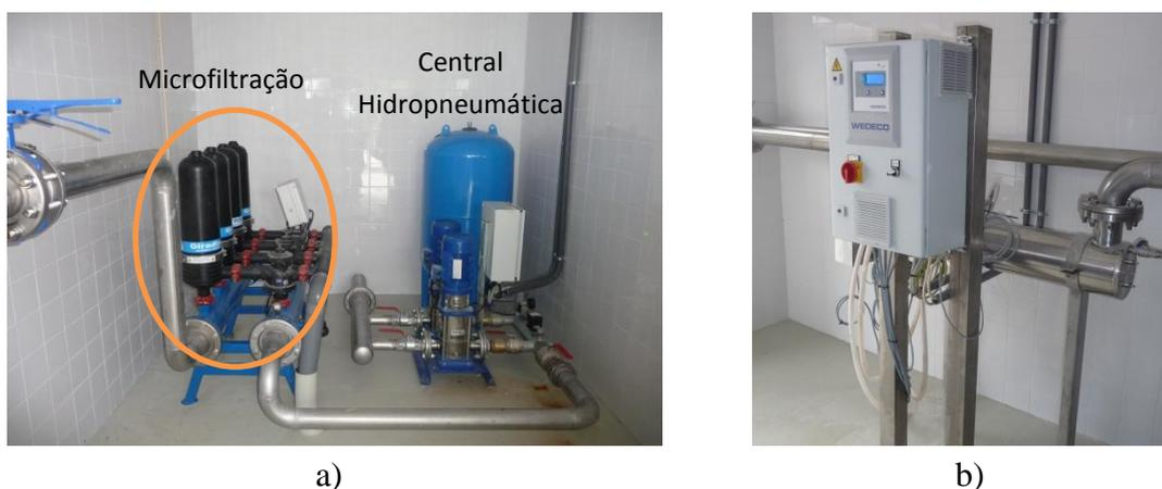
Figura 4.7 – Equipamentos de microfiltração (a) e desinfecção por UV (b).
