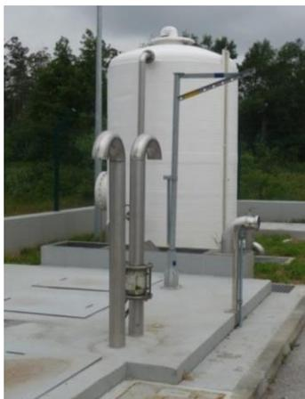
Figura 4.9 – Vista superior do tanque de armazenamento de efluentes provenientes de fossas sépticas e reservatório de água de serviço.
