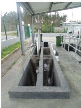
Figura 4.4 – Tamisador rotativo e canal by-pass.
