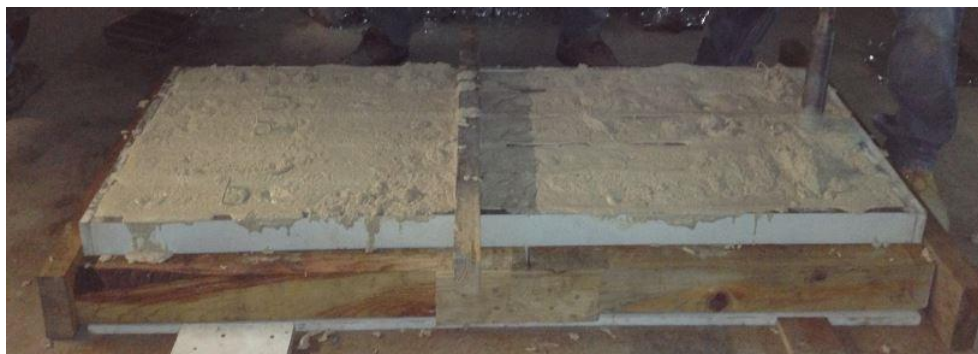
Figura 3.4- Construção das vigas de Metacaulino.
