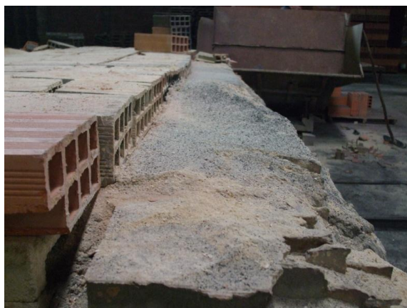
Figura 3.2 – Depósito de cinzas na linha de fabrico (Pormenor).
