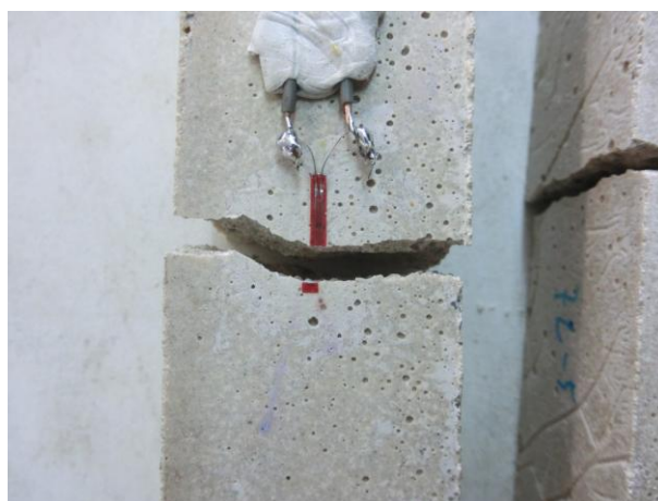
Figura 4.11 - Pormenor da superfície de rotura.
