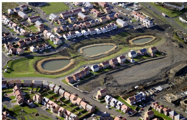
Figura 2.14 – Bacia de retenção localizada na Escócia (SUDSnet@, 2014).
