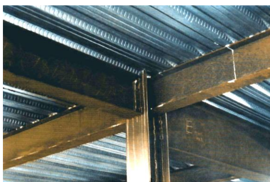
Figura 1.3 – Ligação Assimétrica.
