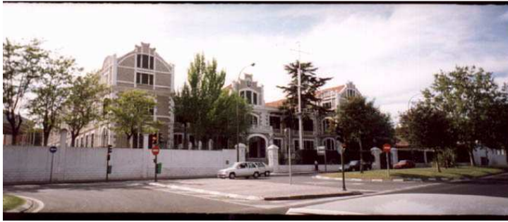
CIDADE LINEAR. COLÉGIO DOS ÓRFÃOS DA ARMADA. BENITO GUITART E EMILIO VARGAS. CONSTRUÍDO EM 1913/16. FOTOGRAFIA DE 1997
