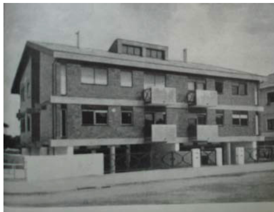
13 Conjunto das quatro habitações na rua S. João de Brito
