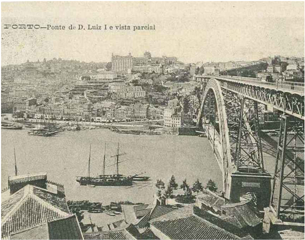
2 Ponte D. Luís I, Porto
