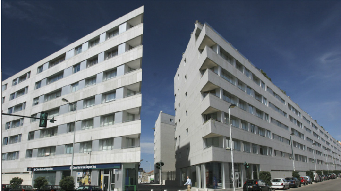
73 Edifícios de Habitação Castelo do Prado, Matosinhos
