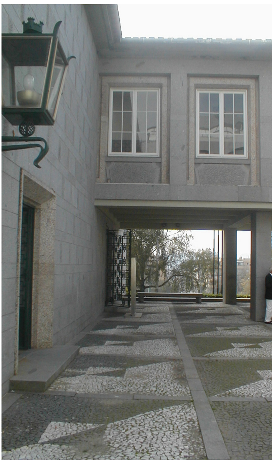
212 Fotografia do preexistente
