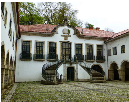
120 Terceiro Claustro do Convento
