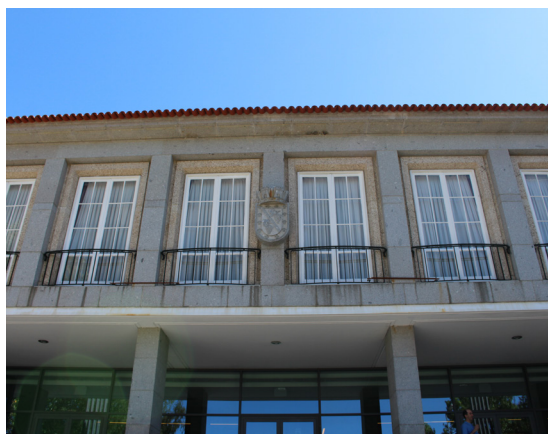
216 Pormenor da Fachada Principal
