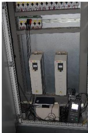
**Figura 3.13** Analisador de energia PEL103 ligado no disjuntor do motor de insuflação de ar da caldeira.
