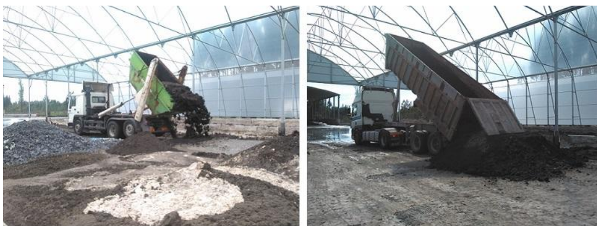
Figura 3.2. Descarga de lamas de depuração na unidade da Bioenergias.
