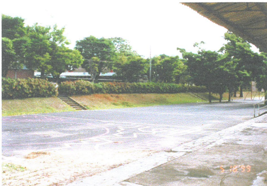
FIGURA 74 - Parte do entorno do edifício, onde se vê nos fundos o pátio em asfalto.
