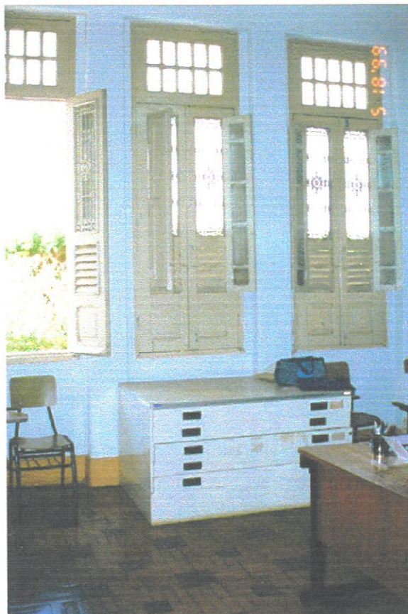
FIGURA 77 - Sala de recepção, onde notam-se as janelas amplas da fachada frontal em madeira, ferro e vidro.
