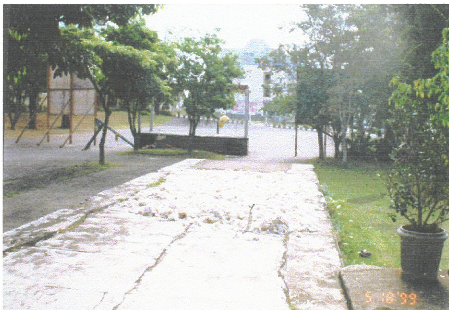
FIGURA 75 - Área do entorno. Vista da lateral esquerda do edifício. No detalhe as lâs usadas para tecelagem secando ao sol.
