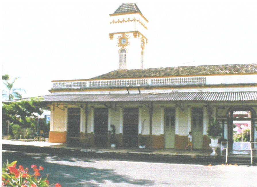
FIGURA 73 - Vista parcial da parte posterior do edifício, na antiga plataforma de embarque.
