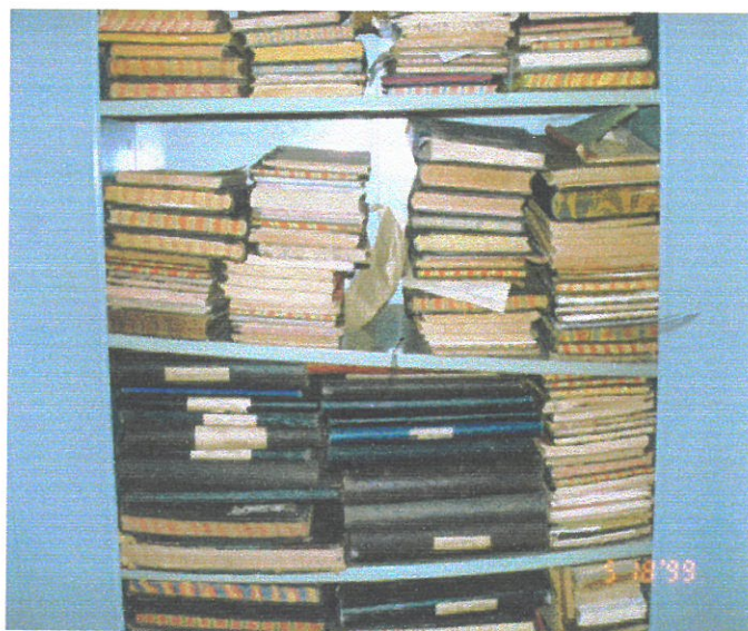
FIGURA 70 - Detalhe do local de armazenagem, onde se vê o empenamento da prateleira.
