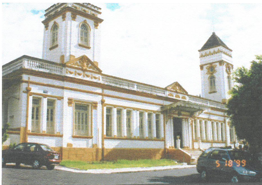
FIGURA 72 - Fachada frontal do edifício, onde são vistas as janelas amplas, as calhas e os elementos decorativos em estilo neoclássico.
