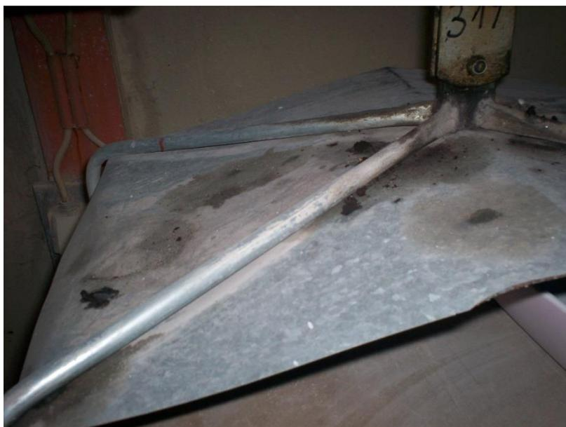
**Figura 1.3.** Acumulação de partículas de massa consistente e material ferroso no chapéu do balancete.
