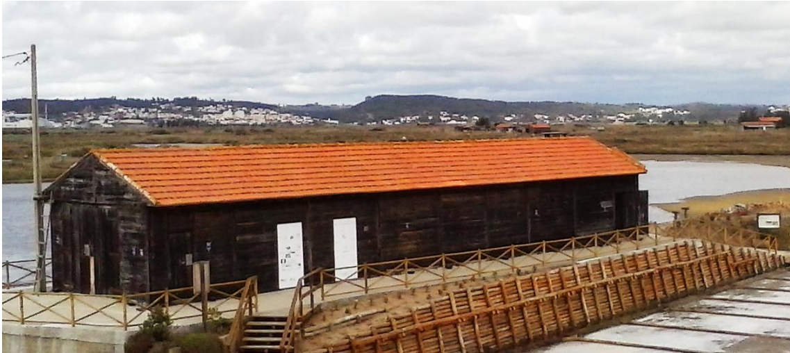
Fotografia 10 – Fachada exterior do armazém de sal da Salina Municipal do Corredor da Cobra.
