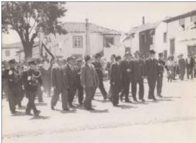
Inauguração da electrificação em Leomil, no tempo de Julião Maria Fernandes, presidente da Junta de Freguesia de Leomil. Anos 60 do séc. XX.
