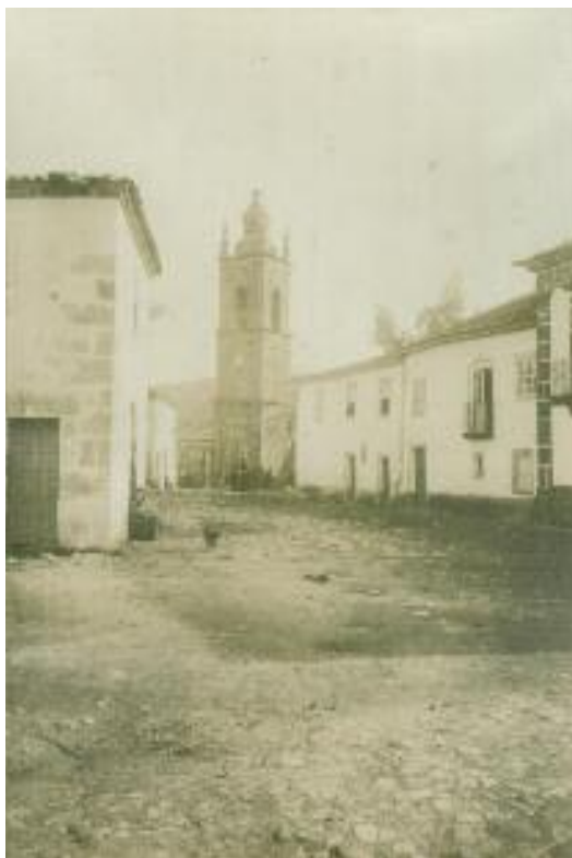
Vista parcial do solar dos Coutinhos, Igreja Matriz e residência paroquial. Primeiro quartel do séc. XX.
