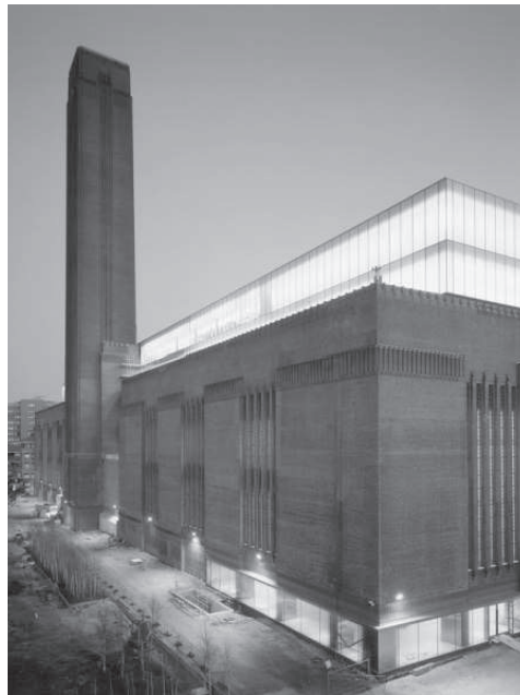
52. Evolução da reconstrução da antiga Central Eléctrica, Bankside, Londres
