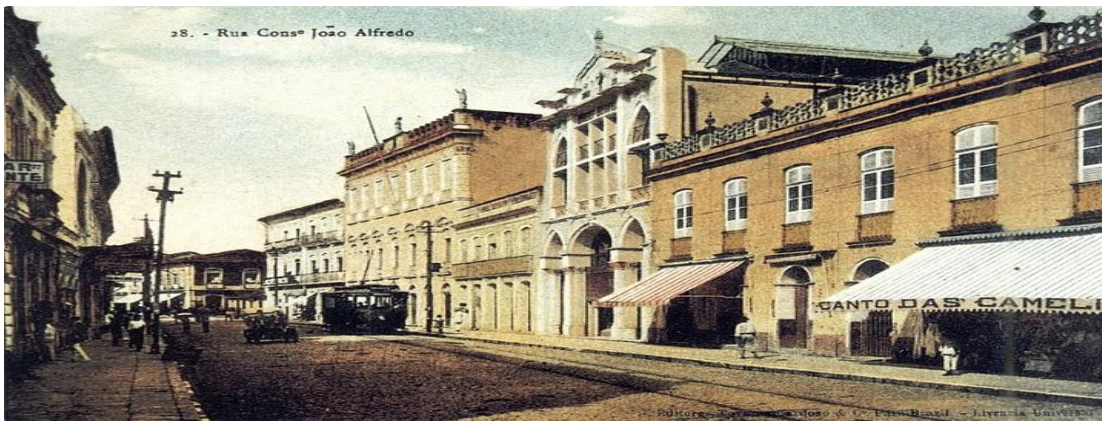
Imagem 8 - Iluminação pública e o carro eléctrico
