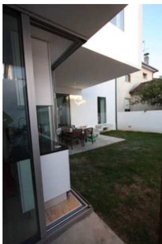
↓ Vista de canto da cozinha com ilustração do sistema de porta de correr que permitem a abertura total da cozinha para o pátio
