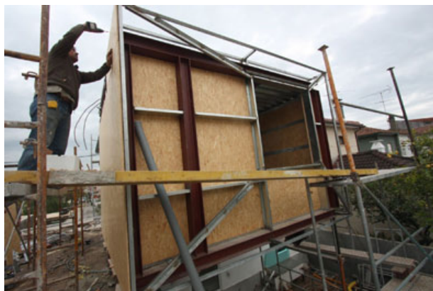
↑ Quarto do primeiro com aplicação dos materiais de revestimentos, designadamente estrutura de suporte para placas OSB e posterior aplicação de sistema ETICS
