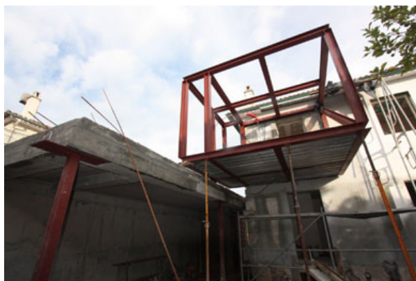
↓ Foto de obra com estrutura metálica do quarto do primeiro andar em destaque
