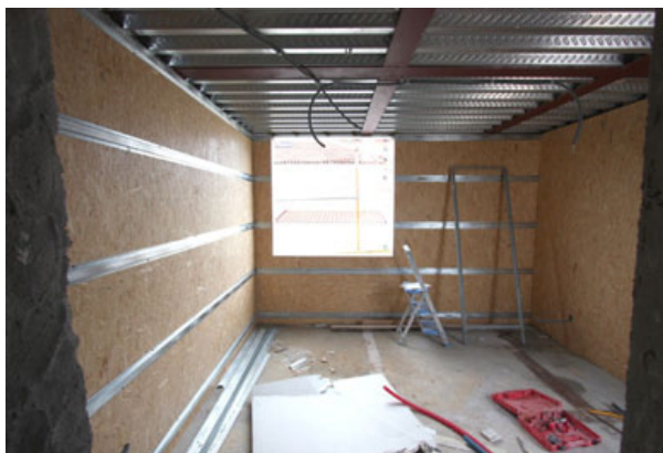
↑ Interior do quarto com aplicação de OSB e estrutura para aplicação de placas de gesso cartonado.
