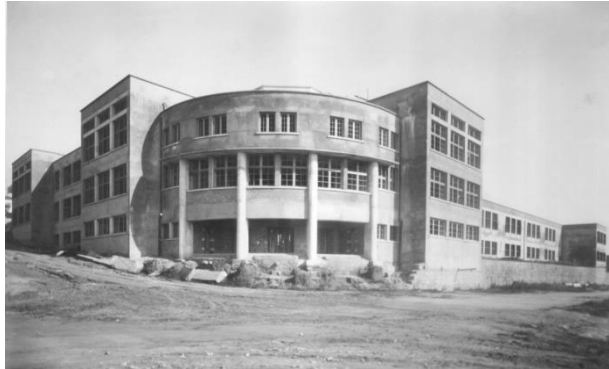
Vista da entrada principal (1936)
