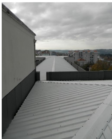
Cobertura do Bloco das salas de aula Fotografia do autor
