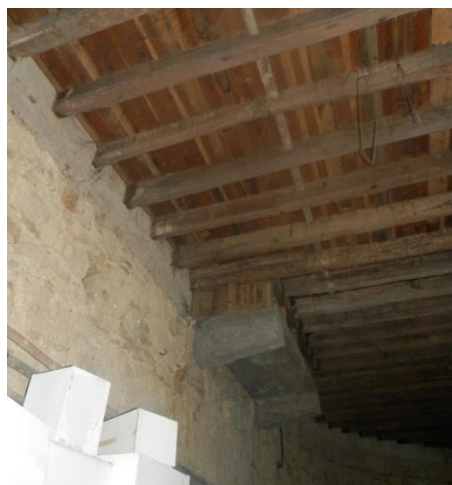
Estrutura por baixo do palco do ginásio Fotografia do autor
