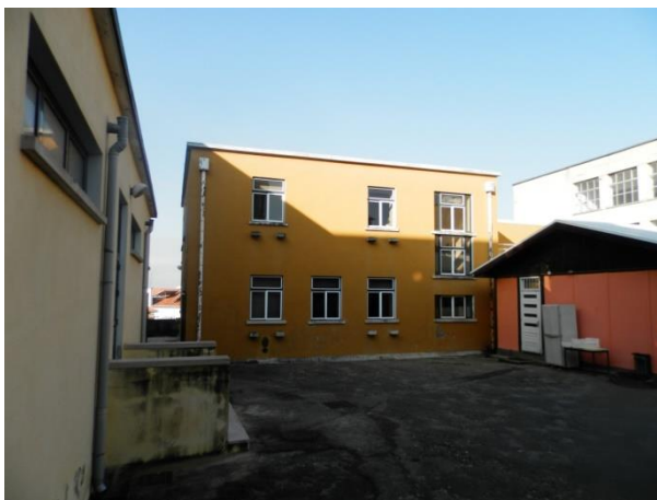
Bloco da antiga casa do reitor e pré-fabricado do bar Fotografia do autor
