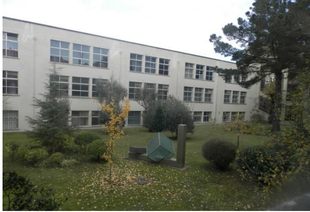
Pátio interior e corredor de circulação
