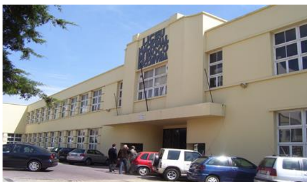
Liceu Diogo de Gouveia - Fachada principal www.parque-escolar.pt
