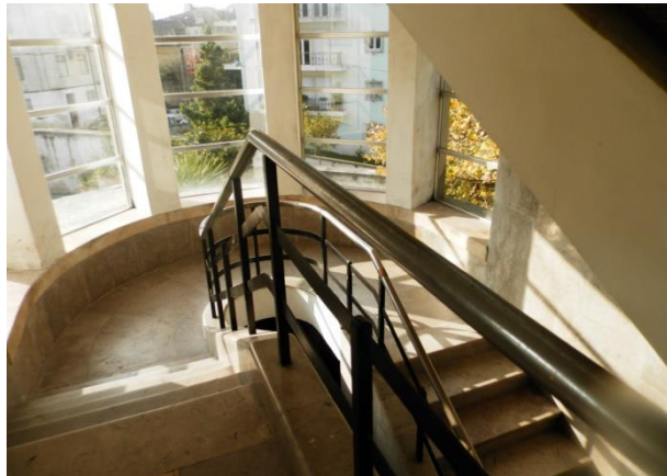
Caixa de escadas – bloco da Educação física Fotografia do autor
