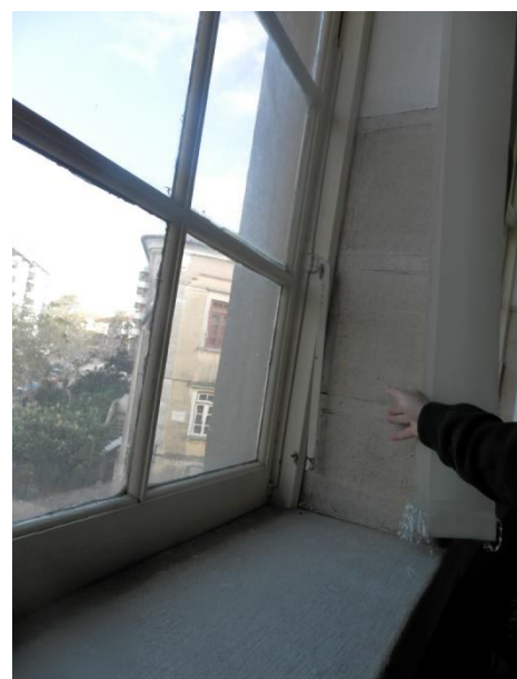
Caixilhos da biblioteca Fotografia do autor
