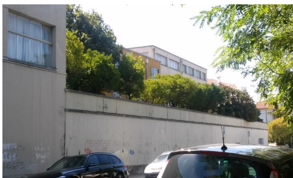
Bloco da antiga casa do reitor – Visto da Avenida D.Afonso Henriques Fotografia do autor
