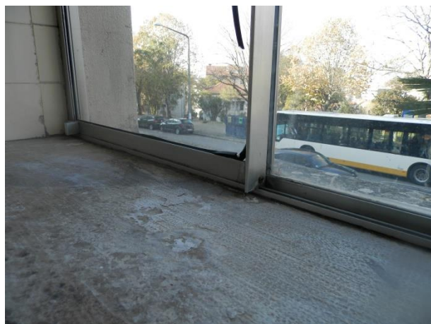
Pormenor do caixilho de alum3nio Fotografia do autor
