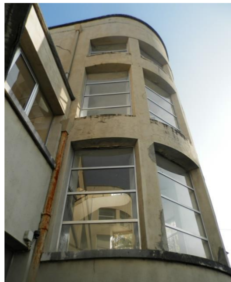
Caixilho na zona de chegada ao bloco da Educação Física
