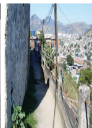
Foto 10 - Rua Convenção Em direção a Rua Augusto Borborema, contenção
