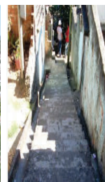
Foto 12 - Rua Convenção Indo em direção a Rua Ti Contel, detalhe
