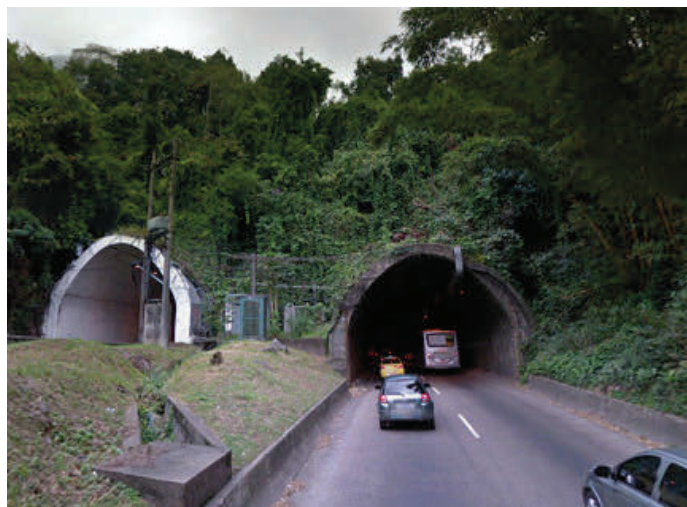
53. Túnel Zuzu Angel, Rio de Janeiro, Brasil
