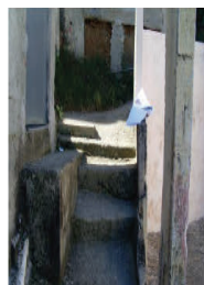
Foto 09 - Rua 07 Detalhe escada
