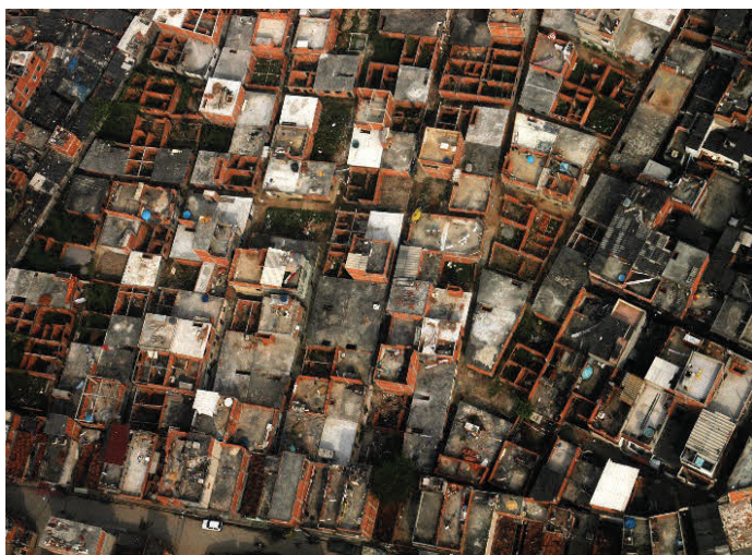
128. Extensão vertical da habitação, Complexo de Manguinhos, Rio de Janeiro, Brasil
