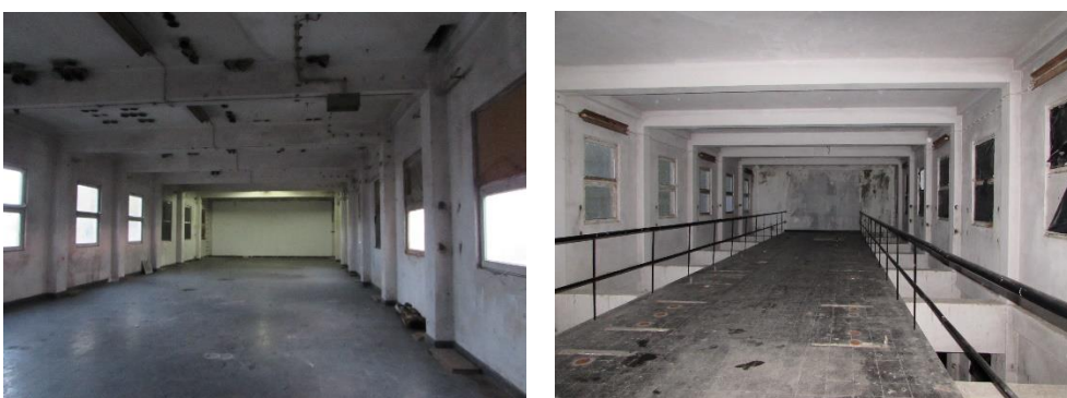
142. Ateliers nos Silos, 5º Piso; 143. 6º Piso
