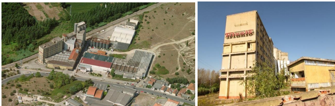
47. Vista de todo o complexo fabril, embora hoje já não apresente a cobertura do pátio
