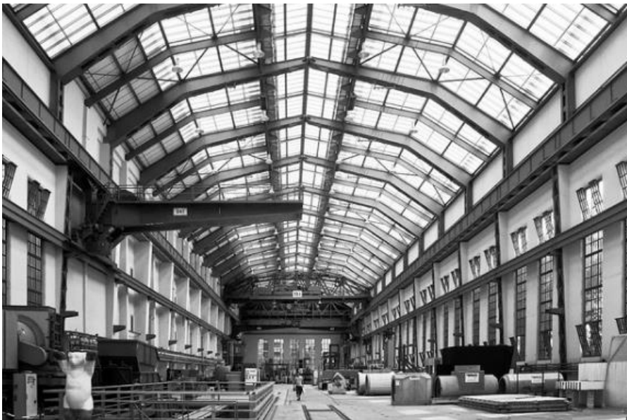
4. Fábrica de Turbinas AEG, Berlim, 1909, Peter Berhens, interior
