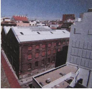
102. Antiga Central Elétrica
