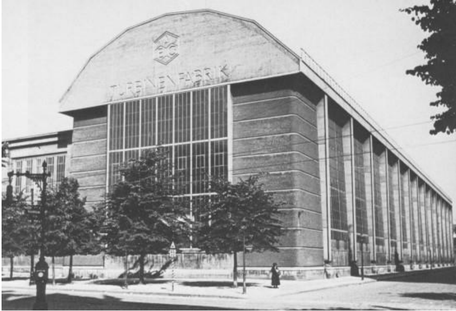
3. Fábrica de Turbinas AEG, Berlim, 1909, Peter Berhens, exterior
