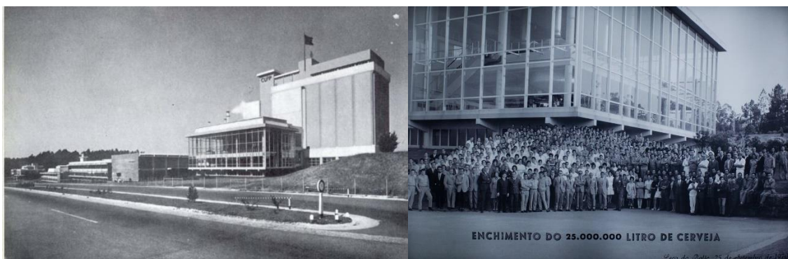
17 e 18. Unicer, 1961-1964 em Leça do Balio, Matosinhos - projeto de Arménio Losa (arquiteto) e João Tolone (engenheiro). Com uma linguagem arquitetónica vanguardista (encontrada na fábrica Van Nelle) e com o uso dos novos métodos, apresenta um corpo fechado de betão, onde é anexado um volume translúcido, traduzindo-se numa transparência do processo de fabrico e imagem da empresa. Foi designado pela Organização de Arquitectos Modernos, um exemplo qualificado de um programa industrial moderno. 35
