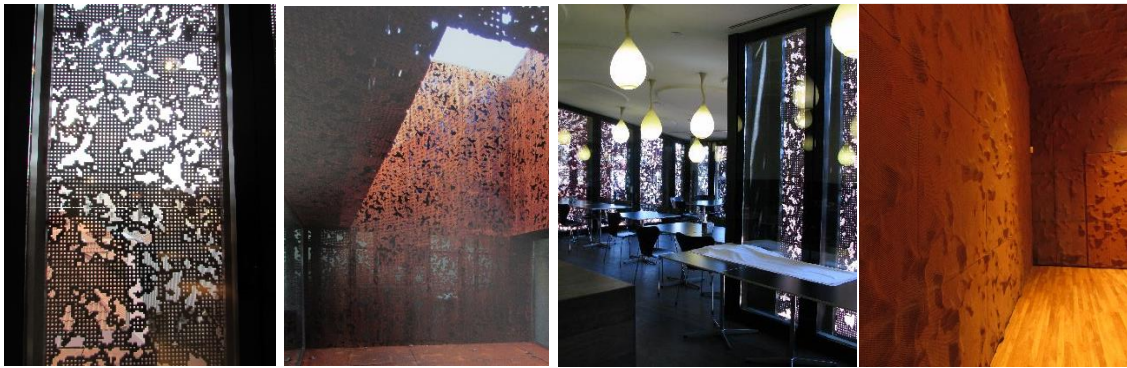
110, 111 e 112. CaixaForum, a utilização do aço-corten; 113. placas metálicas moldadas
