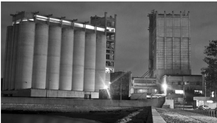
15. Silos da Nutasa, localizada no Quimiparque do Barreiro, para produção de ração de animais, agora usados como tela de projeção no evento “Barreiro Light On”.
