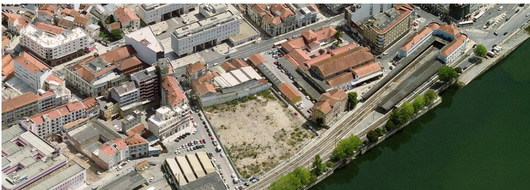
34. Vazio urbano, após a demolição da Fábrica Triunfo
