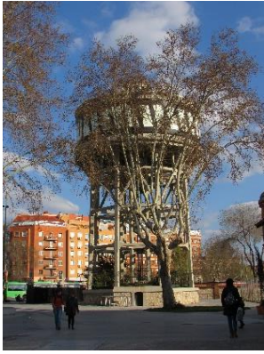
62. Depósito de Água
