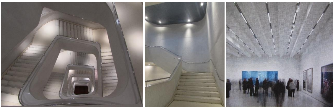
117, e 118. CaixaForum, a utilização de betão nas escadas internas; 119. O branco das salas de exposição
