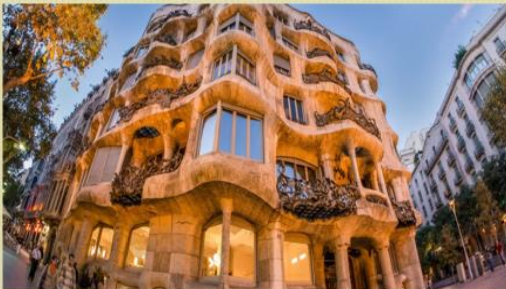
La Pedrera, Barcelona
