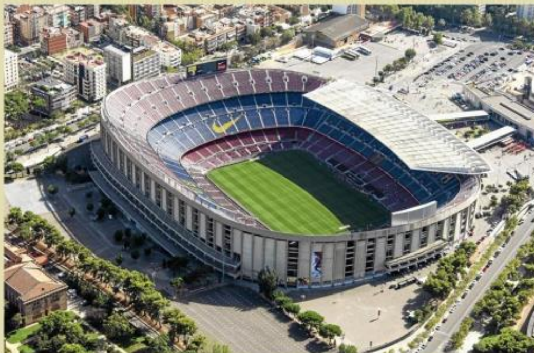
Imagen aérea del Camp Nou, estadio de FC Barcelona
