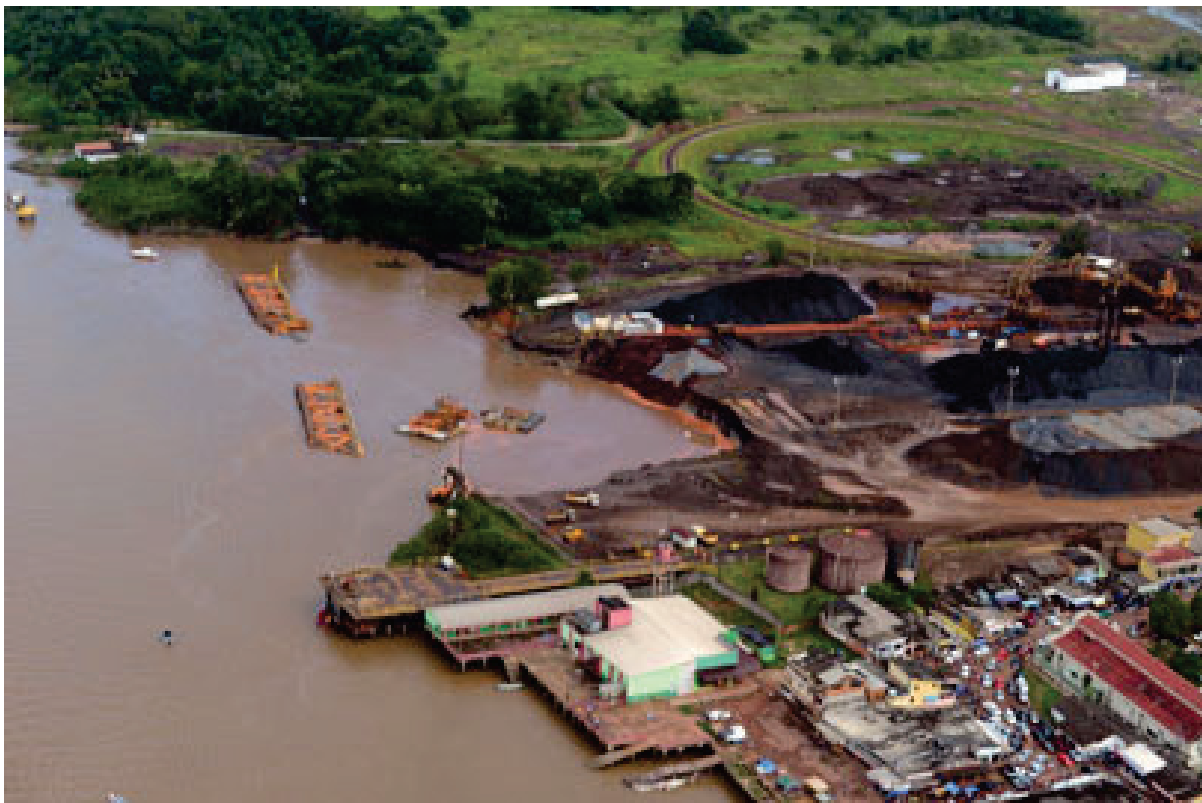
Fotografia 15: Vista geral do Terminal de Uso Privativo com a estrutura submersa do antigo cais flutuante utilizado para o transbordo de minério construído pela ICOMI após o movimento de massa ocorrido em 2013. Fonte: Foto divulgação do DNPM (2013).
