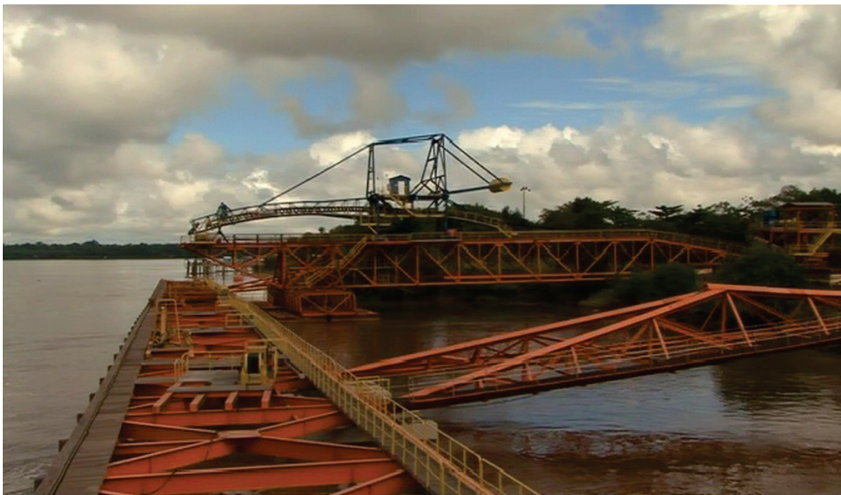
Fotografia 10: Estrutura original do cais de transbordo de minério construído pela ICOMI Fonte: Fonte: Dr. Antunes,2012.
