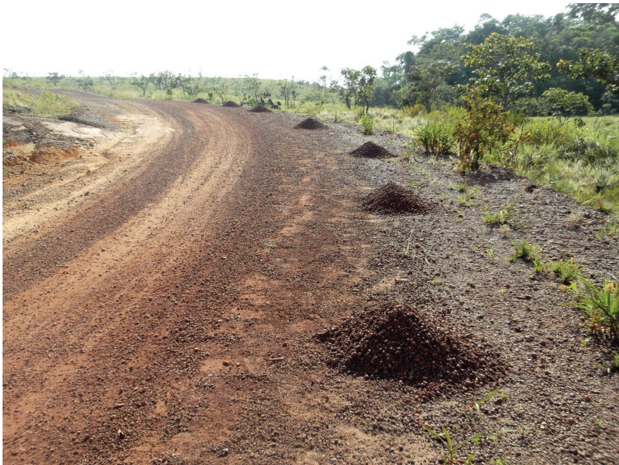
Fotografia 22: Monturos de laterita para sinalização e amortecimento (efeito caixa de brita) colocados nas curvas do Ramal que leva à Vila de Bom Jesus.
