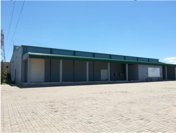
Figura 05: Área Externa do Galpão de Produção
