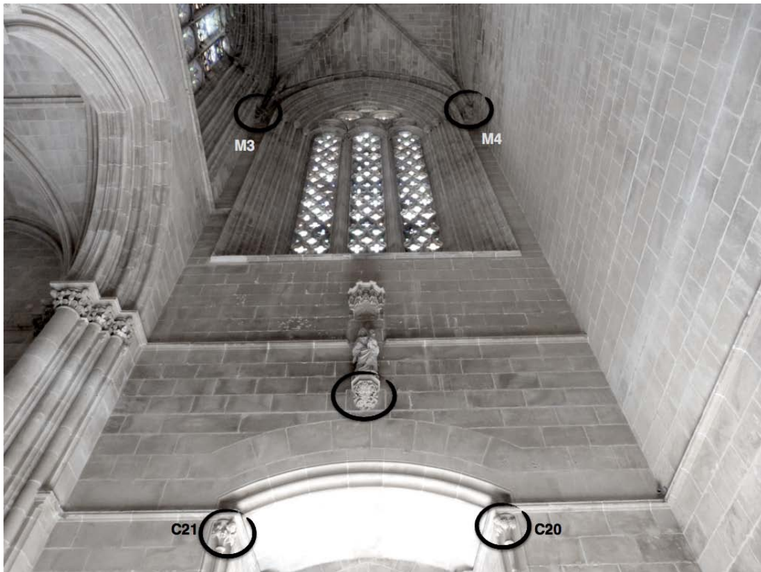
Fig. 9.24- Face interna do portal/braço do transepto sul, distribuição do ornamento marginal © Joana Antunes
