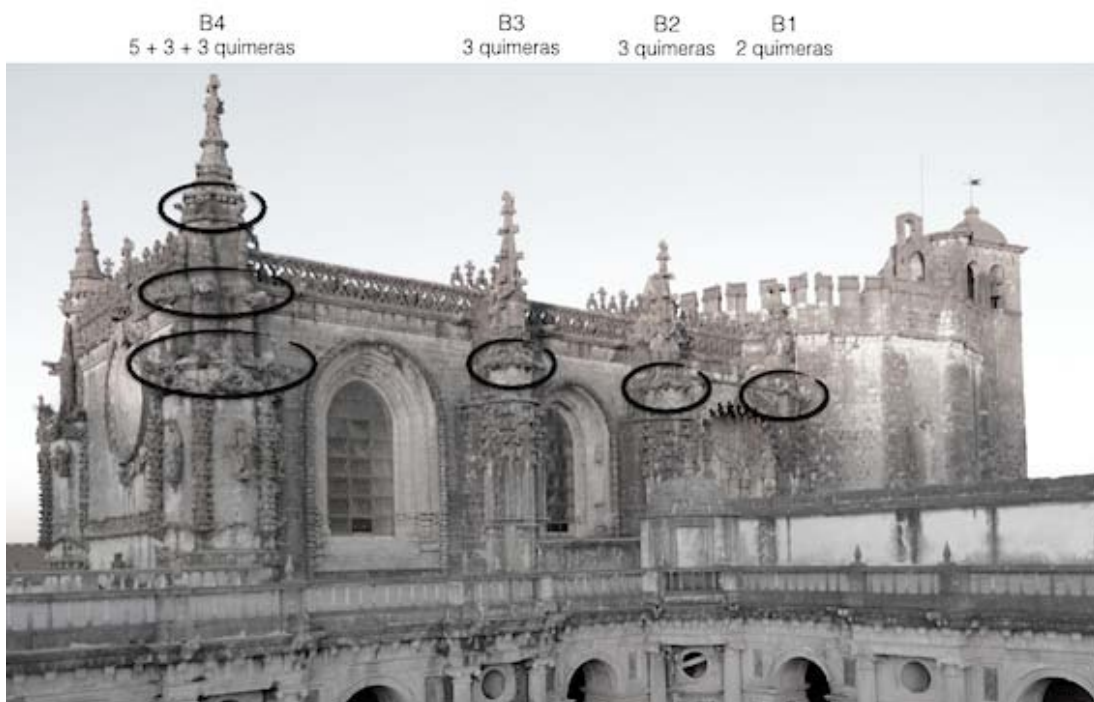
Fig. 6.15 - Convento de Cristo, fachadas sul e ocidental, localização das quimeras e respectiva organização em cada botaréu © Joana Antunes
