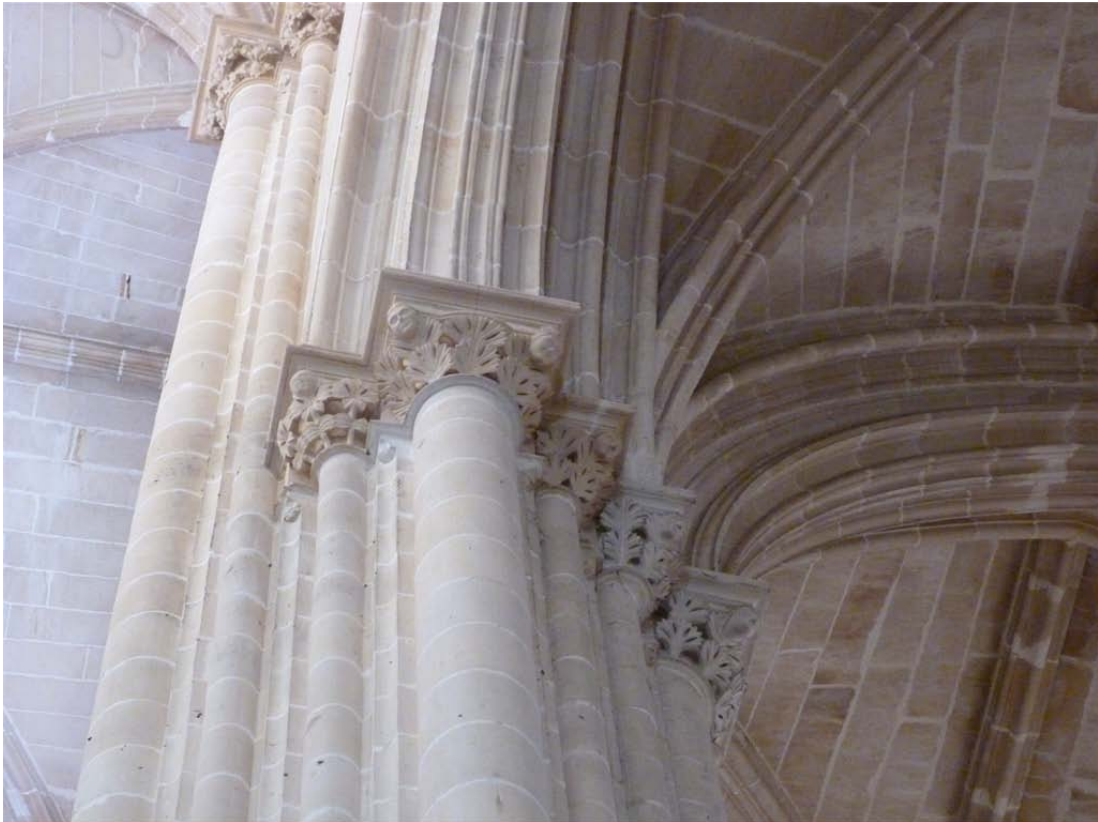
Fig. 9. 33 - Vegetalismos habitados, naves da igreja © Joana Antunes
