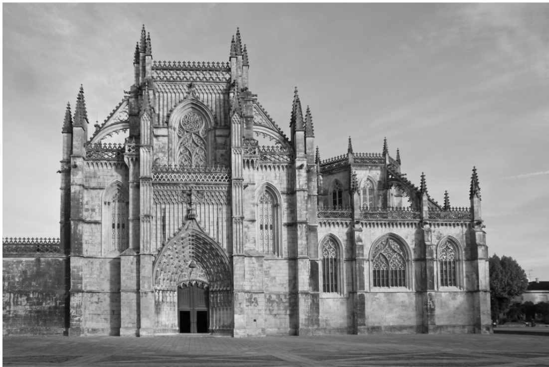
Fig. 7.4 - Mosteiro de Santa Maria da Vitória, fachada ocidental, séc. XV © wikicommons
