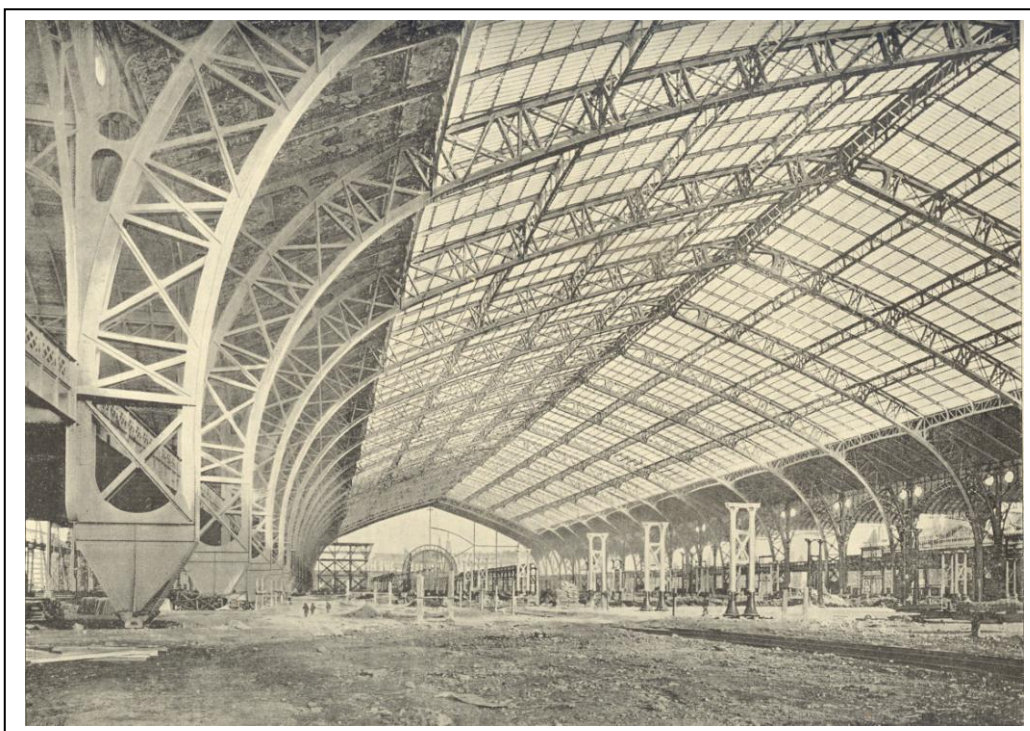
Ilustração 63: Fotografura com a “Galeria das Machinas” nos fins de Fevereiro de 1889 63 .
