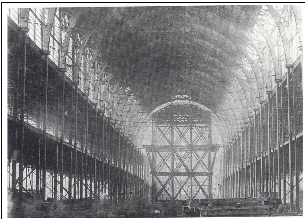
Ilustração 13: Construção da nave central do palácio da exposição de Londres 1862 13 .
