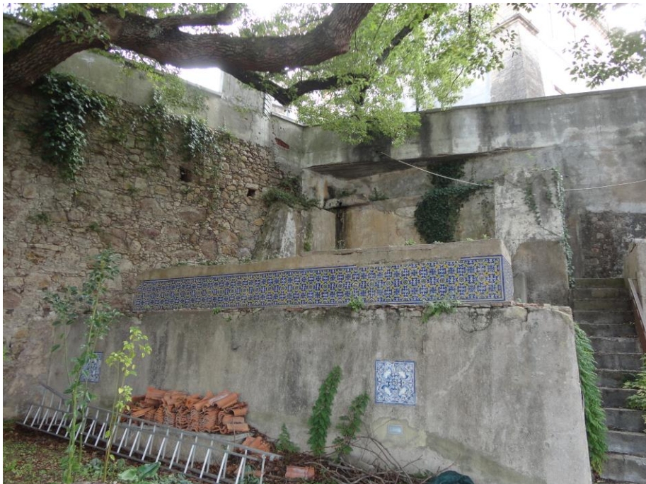
7./Ilustração 34: Fotografia de alguns vestígios de edificações, a poente da torre da Sé, contíguas ao muro que se prolonga para sul. Fotografia de 15 de Outubro de 2012, da autoria de Jorge Ferreira.
