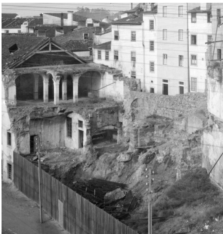
9./Ilustração 105: Fotografia após a demolição da torre dos sinos de Santa Cruz, em 3 de Janeiro de 1935. Gentilmente cedida por Jorge Ferreira.
