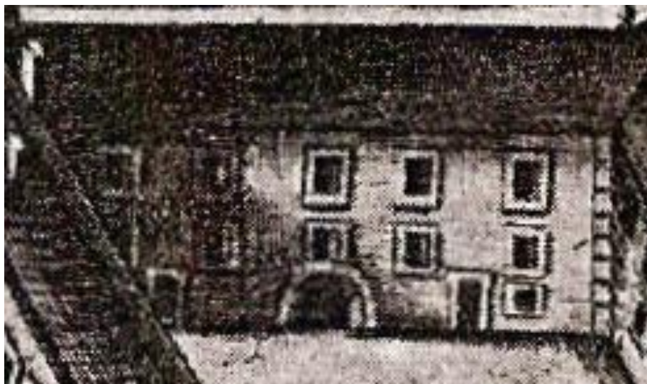
8./Ilustração 146: Extracto da imagem do Colégio da Companhia de Jesus, de 1732, da autoria de Grandi (Silva, 1964, est. 8). Pormenor que mostra a fachada norte do claustro noroeste, onde se insere um arco, bastante enterrado que deverá corresponder a uma pré-existência uma vez que não se enquadra, arquitetonicamente, na fachada em que se insere.
