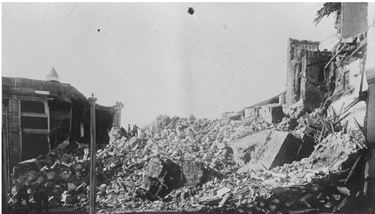
9./Ilustração 104: Fotografia após a demolição da torre dos sinos de Santa Cruz, em 3 de Janeiro de 1935. ANTT, Fundos fotográficos, Fundo EPJS (série ficheiro central), cliché nº 25 J.
