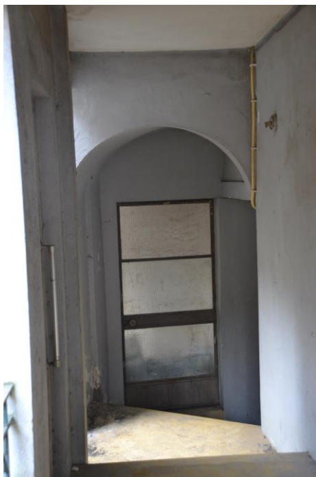
9./Ilustração 118: Atravessamento sob parede com espessura de cerca de 2.10m, existente no edifício do Pátio da Inquisição. Fotografia da autoria de Jorge Ferreira, de 20 de Junho de 2013.
