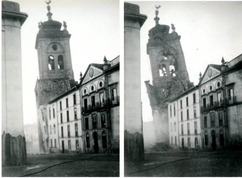
9./Ilustração 100: Fotografias da demolição da torre dos sinos de Santa Cruz, em 3 de Janeiro de 1935, nas quais se vê a fissuração das paredes da torre imediatamente antes da queda, indicando duas zonas distintas, a norte e a sul. Fotografias gentilmente cedidas por Jorge Oliveira.
