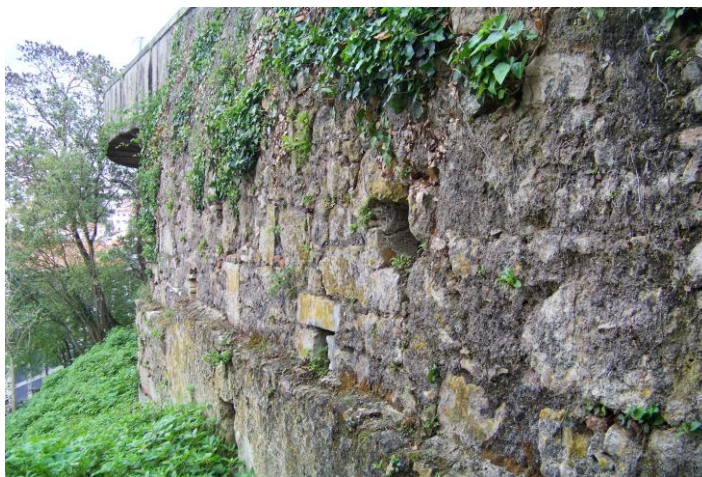
8./Ilustração 130: Muros a norte na antiga cerca dos Jesuítas. Fotografia da autoria de Jorge Ferreira, de 22 de Outubro 2012.
