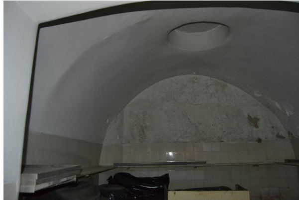
8./Ilustração 103: Cisterna do colégio das Artes. Esta abóbada encontra-se hoje num piso intermédio que não existia no edifício original, construído para efeitos da utilização hospitalar que teve. Fotografia de Jorge Ferreira de 10 Dezembro de 2012.
