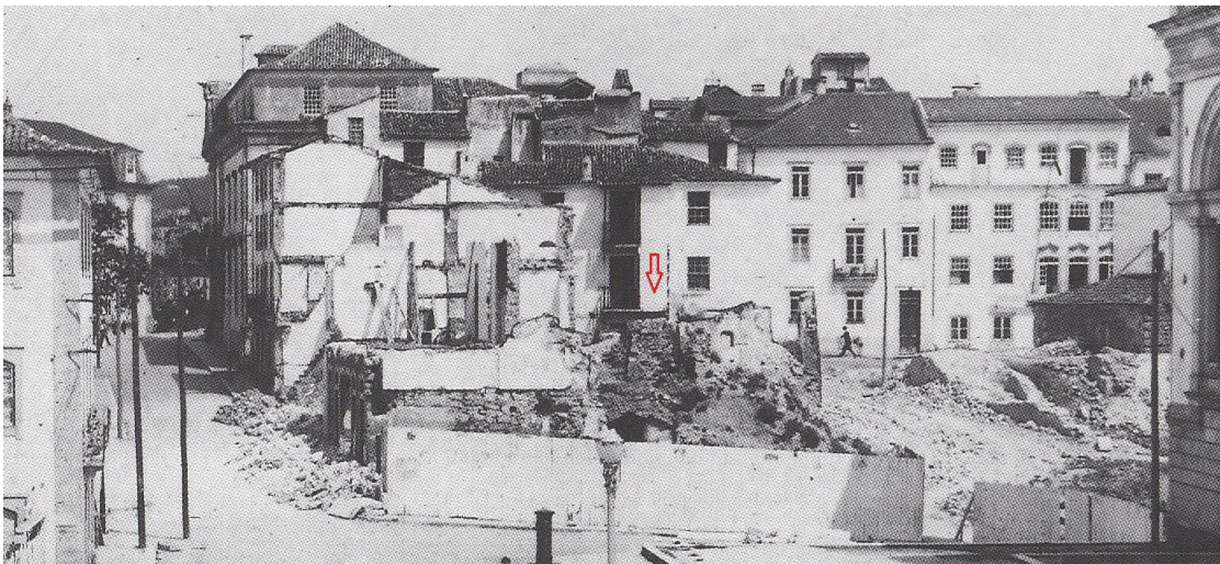
7./Ilustração 53: Fotografia de cerca de 1945 pois já se encontra demolida a igreja de S. Pedro, o que aconteceu em 1944/1945, mas ainda não se encontra em construção a nova Faculdade de Letras (à esquerda), iniciada em Dezembro de 1945. Retrata-se as demolições nas obras da cidade universitária. Nela se vê, no quarteirão contíguo à igreja de S. Pedro, um espesso muro (assinalado por uma seta a vermelho) onde terá existido a torre sineira da referida igreja. Fotografia gentilmente cedida por Jorge Ferreira.
