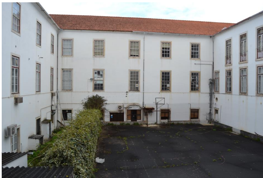
8./Ilustração 147: Fachada sul do claustro noroeste do antigo edifício do Colégio da Companhia de Jesus. Fotografia de Jorge Ferreira de 5 de Março 2013.
