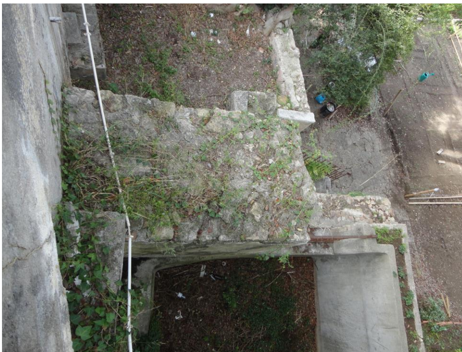
7./Ilustração 37: Fotografia, de 15 de Outubro de 2012, de vestígios de edificações contíguas ao muro que se prolonga para sul, a poente da torre da Sé. O muro tem de 1.32m de espessura, e está apoiado numa base ainda mais larga. Poderá estar relacionado com a torre constante da planta de 1773, figurada na ilustração 30. BGUC, Álbums Pombalinos da BGUC, MS-3377-43_0001_1_t24-C-R0120. MNMC, Desenhos de Arquitectura, DA 116. Fotografia da autoria de Jorge Ferreira.
