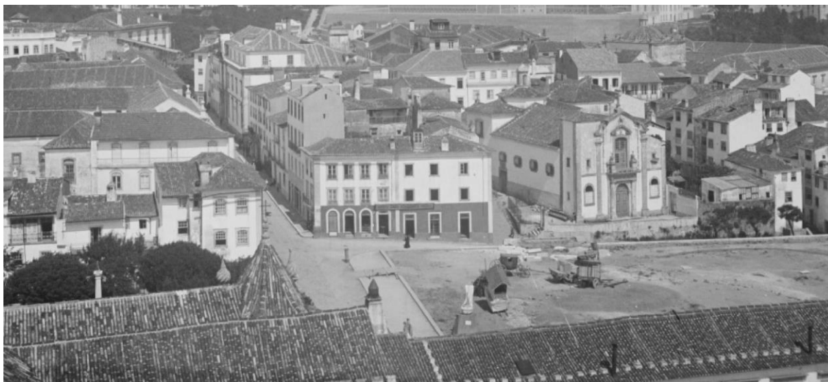
7./Ilustração 48: Extracto de fotografia de Aurélio da Paz dos Reis, de 1899, no qual se pode ver a igreja de S. Pedro e o terreiro onde se situara o Colégio Real de S. Paulo, bem como comparar os níveis altimétricos do terreno. Fotografia gentilmente cedida por Jorge Oliveira.
