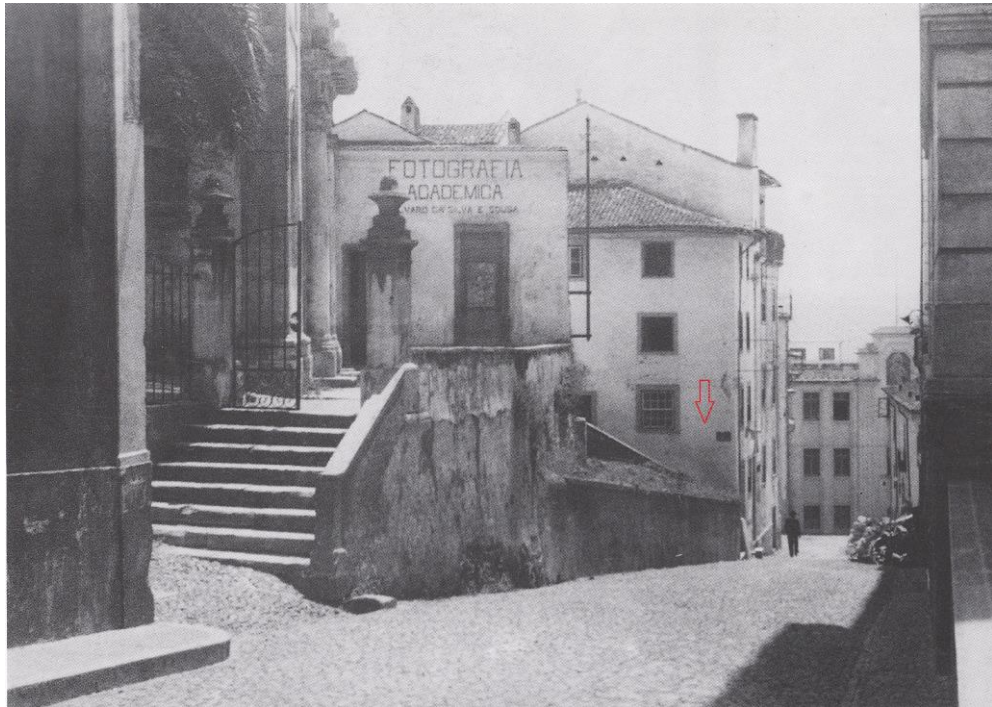
7./Ilustração 50: Fotografia da rua de S. Pedro, seguramente posterior a 1912 uma vez que já se encontra construído o novo edifício da Faculdade de Letras do Arq.º Silva Pinto. Nela é possível apreciar o desnível, de cerca de 2.00m, relativamente à entrada da igreja de S. Pedro, decorrente da construção da FLUC (mais tarde transformada em Biblioteca Geral). A seta assinala o que creio corresponder ao atravessamento de um antigo muro, ainda existente em c. 1899, mas que aqui já se encontra cortado [vide 7./Ilustrações 46 e 47] e cujo derrube terá originado grandes alterações altimétricas ( A velha Alta... , 1984, p.116).
