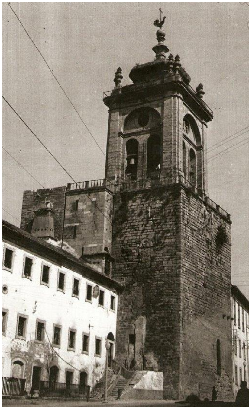
9./Ilustração 89: Fotografia dos alçados poente e sul da torre dos sinos de Santa Cruz, edificada sobre uma torre anterior, esta última podendo fazer parte de um conjunto acastelado a norte do mosteiro. Fotografia gentilmente cedida por Jorge Oliveira.
