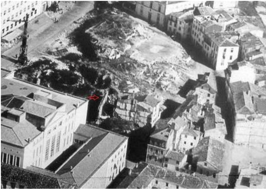
7./Ilustração 52: Extracto de fotografia de 1959 de quando se procedia ao rebaixamento do terreno onde se implantaria a Faculdade de Ciências, durante as demolições das obras da cidade universitária. Nele qual se pode ver, assinalado por uma seta a vermelho, o que parece ser um muro no local onde se situava a igreja de S. Pedro. Fotografia gentilmente cedida por Jorge Oliveira.
