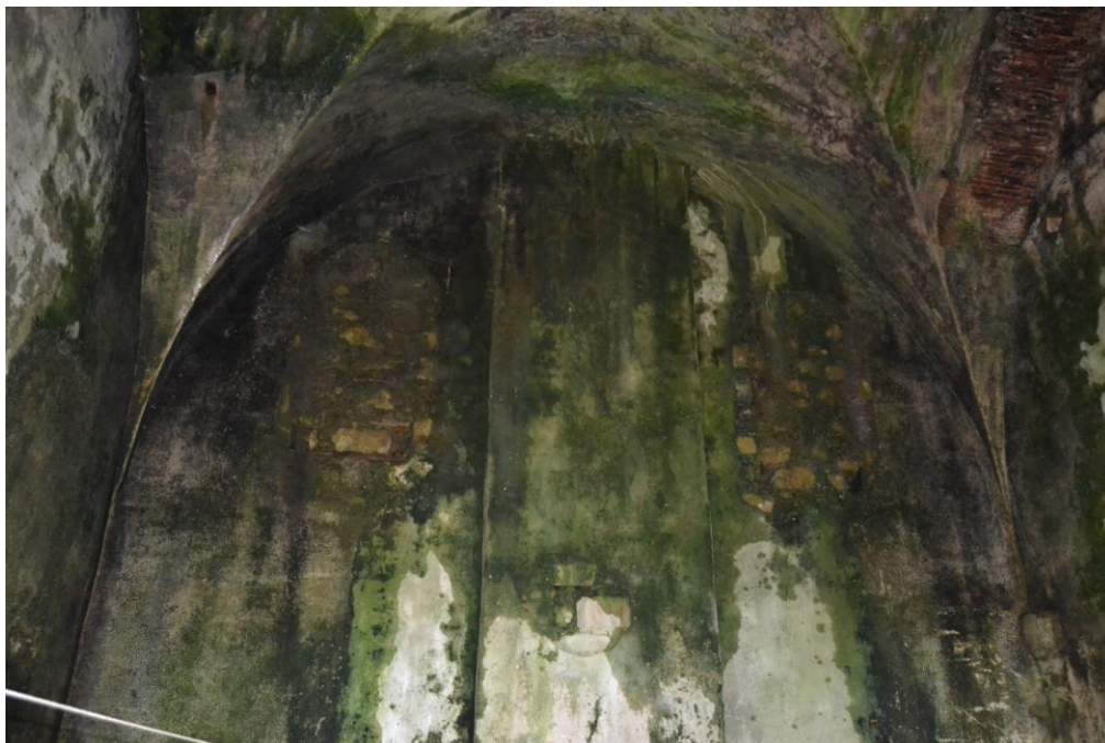
7./Ilustração 22: Fotografia, de 28 de Julho de 2014, do interior da torre da Sé (fachada sul), da autoria de Jorge Ferreira. Existem dois vãos entaipados, mais altos que o da fachada nascente (ver figura anterior).
