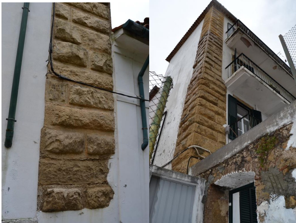
7./Ilustração 76: Fotografias dos cunhais, noroeste e sudoeste, da fachada do Colégio de Santo António da Pedreira. Segundo os autores do Inventário Artístico, o aparelho rusticado dos cunhais aparecia também em algumas frestas antigas (Correia & Gonçalves, 1947, II, p.148). Fotos de 11 de Abril de 2013, da autoria de Jorge Ferreira.
