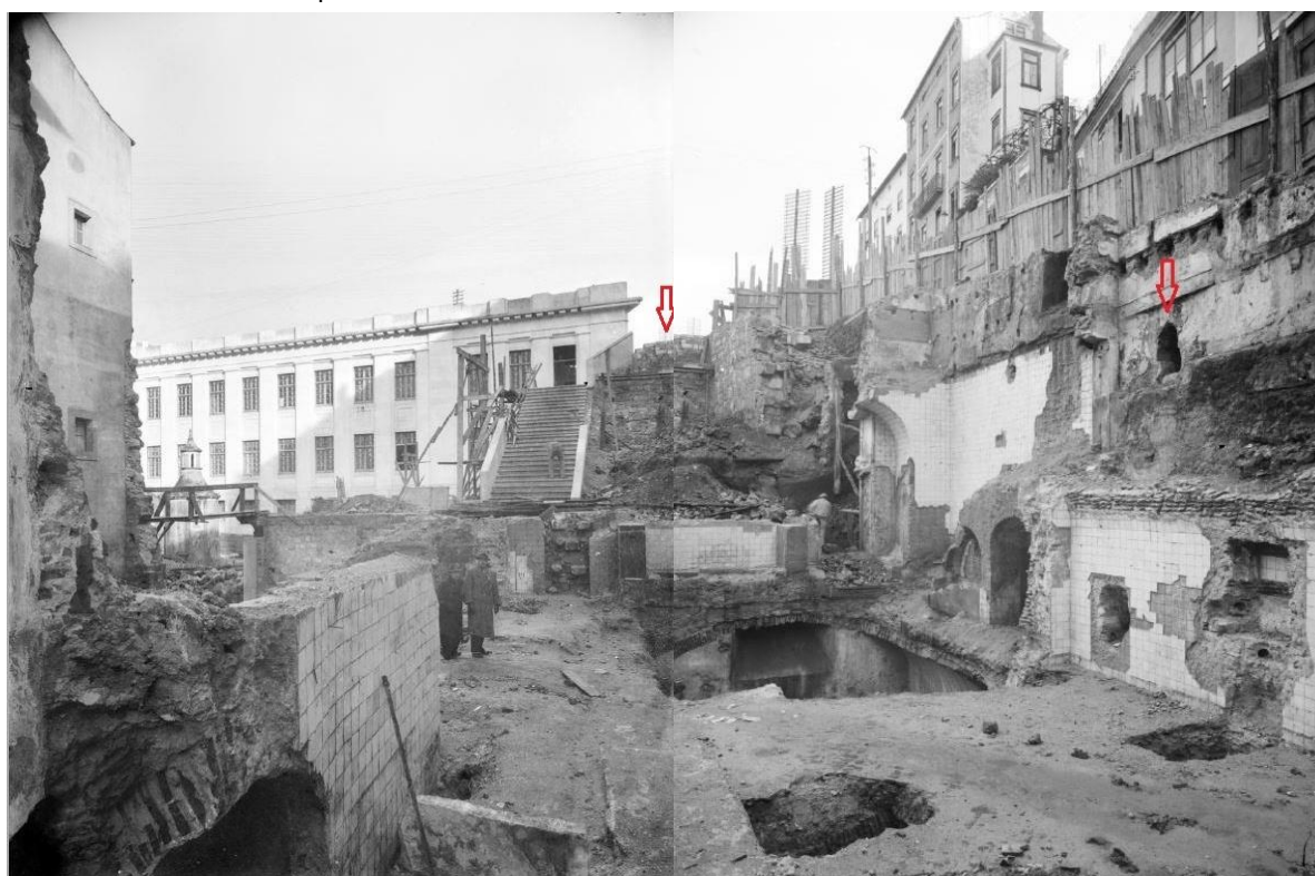
9./Ilustração 113: Fotografias de Domingos Alvão, gentilmente cedidas por Jorge Ferreira, referentes à demolição das cozinhas do mosteiro de Santa Cruz. Encontram-se assinalados, com uma seta a vermelho, o que parece ser uma conduta de água e um muro (com grande espessura) a nascente daquela.
