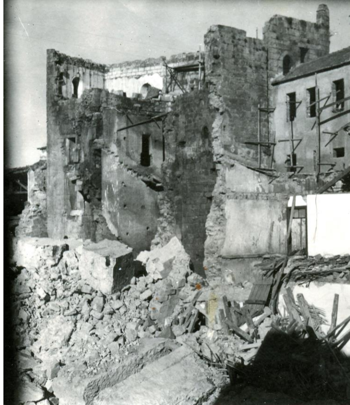
9./Ilustração 102: Extracto de fotografia após a demolição da torre dos sinos de Santa Cruz, em 3 de Janeiro de 1935. Gentilmente cedida por Jorge Oliveira.
