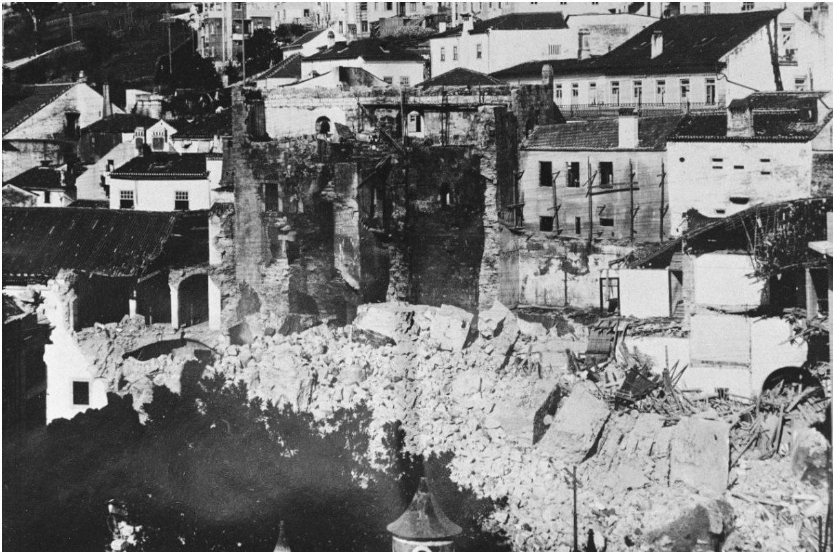
9./Ilustração 101: Fotografia após a demolição da torre dos sinos de Santa Cruz, em 3 de Janeiro de 1935. ANTT, Fundos fotográficos, Fundo EPJS (série ficheiro central), cliché nº 26 J.
