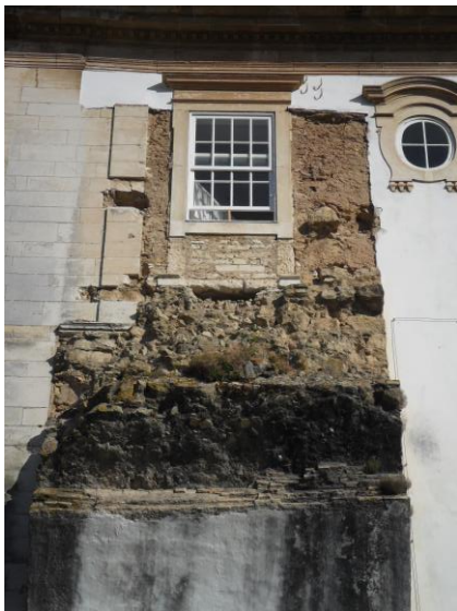
8./Ilustração 84: Sinais na fachada sul do Colégio de S. Jerónimo da passagem superior que existiu sobre o “arco Grande” (o arco de reforço mais a poente dos três “arcos botaréis” lançados em 1687). Fotografia da autora de 6 Novembro de 2010. E alçado sul do colégio de S. Jerónimo, integrante do projecto de adaptação aos hospitais da Universidade de Coimbra, de 1884, da iniciativa de António Augusto da Costa Simões, que se encontra na Biblioteca Geral da Universidade de Coimbra (BGUC, UCSIB-MS-3379_0010).
