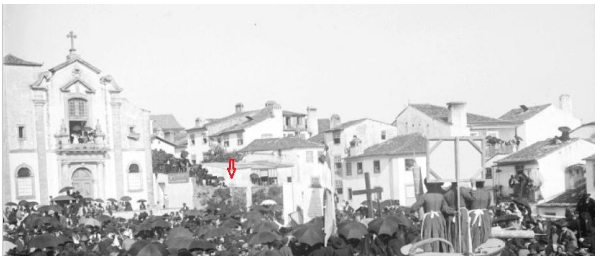
7./Ilustração 49: Fotografia possivelmente de c. 1899 (pois a ilustração 48 é desta data e não se encontra ainda construído o novo edifício da FLUC, construção que se iniciou em 1912). Nela se pode ver um muro contíguo à igreja de S. Pedro (assinalado a vermelho), muro esse que parece continuar fechando o terreiro do lado sul. Fotografia gentilmente cedida por Jorge Oliveira.
