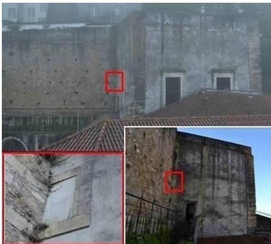
7./Ilustração 17: Fotografias, de 2 de Fevereiro de 2013, da fachada nascente da torre da Sé, da autoria de Jorge Ferreira. Destaca-se, a vermelho, um vão seccionado pela muralha a sul, eventualmente aquando de alguma remodelação desta última.
