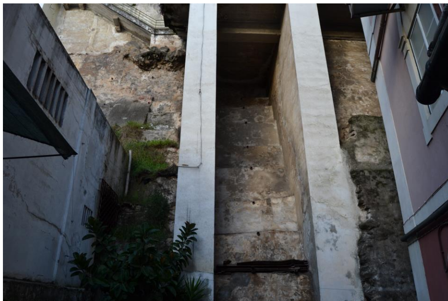
9./Ilustração 36: A pedreira ainda visível na zona da Alegria. Fotografia da autoria de Jorge Ferreira, de 29 de Janeiro de 2013.
