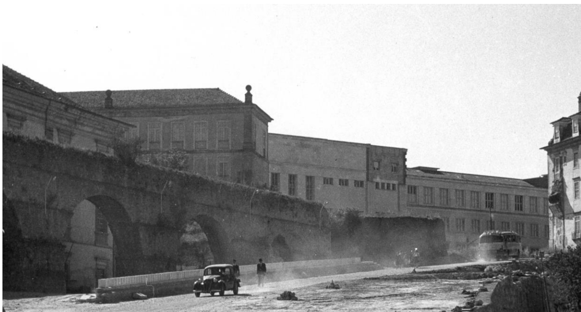
8./Ilustração 155: Fotografia das demolições da Alta onde é possível aferir que o troço de aqueduto está à mesma altura da barbacã do Castelo. Extracto de imagem gentilmente cedida por Jorge Oliveira.
