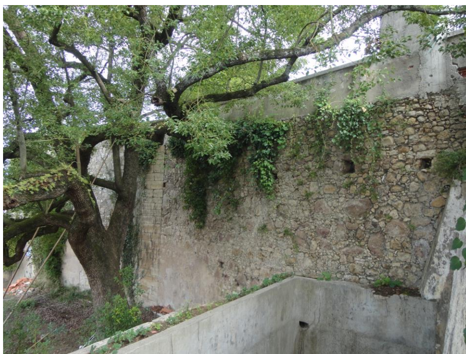
7./Ilustração 38: Fotografia, de 15 de Outubro de 2012, com a marcação, em silharia, do limite da torre da Sé, podendo tratar-se do seu cunhal sudoeste aparentemente transformado em pilastra. Fotografia da autoria de Jorge Ferreira.
