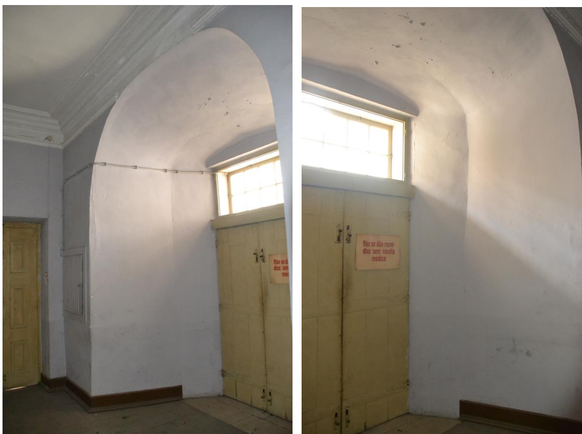
9./Ilustração 117: Porta, no edifício do Pátio da Inquisição, aberta em parede com espessura de cerca de 2.10m. Fotografias da autoria de Jorge Ferreira, de 20 de Junho de 2013.
