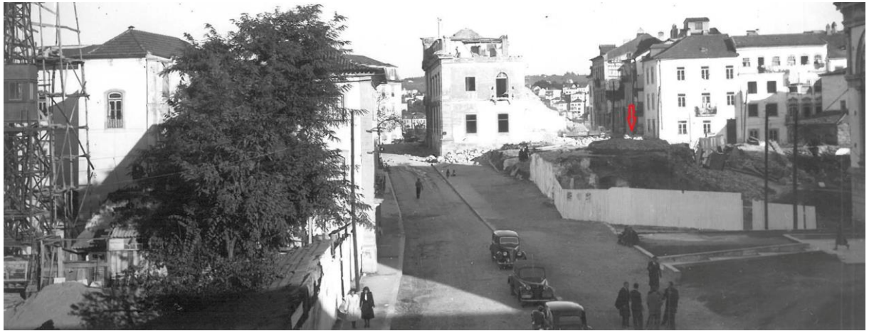
7./Ilustração 54: Fotografia de cronologia um pouco posterior à da ilustração 53, por volta de 1948. De facto, já se encontra demolida a igreja de S. Pedro o que aconteceu em 1944/1945, mas encontra-se em construção a nova Faculdade de Letras (à esquerda), iniciada em Dezembro de 1945 mas só concluída em 1951. Nela se vê, no quarteirão contíguo à igreja de S. Pedro, um espesso muro (assinalado por uma seta a vermelho) na zona onde terá existido a torre sineira da referida igreja. Fotografia gentilmente cedida por Jorge Ferreira.
