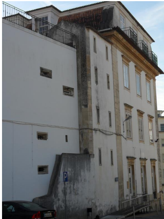
8./Ilustração 66: A torre dos sinos, cortada, da antiga igreja de S. Jerónimo e maciço contíguo (aproveitado para caleira). Fotografia da autora, de 6 de Novembro de 2010.
