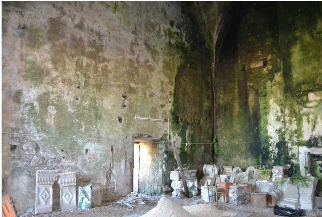
7./Ilustração 21: Fotografia, de 2 de Fevereiro de 2013, do interior da torre da Sé (fachadas nascente e sul), da autoria de Jorge Ferreira.
