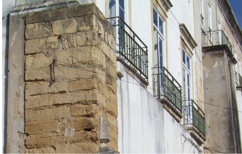
8./Ilustração 13: Cunhal a norte da porta a nascente existente no castelo e distorção na fachada nascente do Colégio de S. Jerónimo, visível a partir do apoio das consolas das varandas. Foto da autoria de Jorge Ferreira, de 20 de Outubro de 2012.
