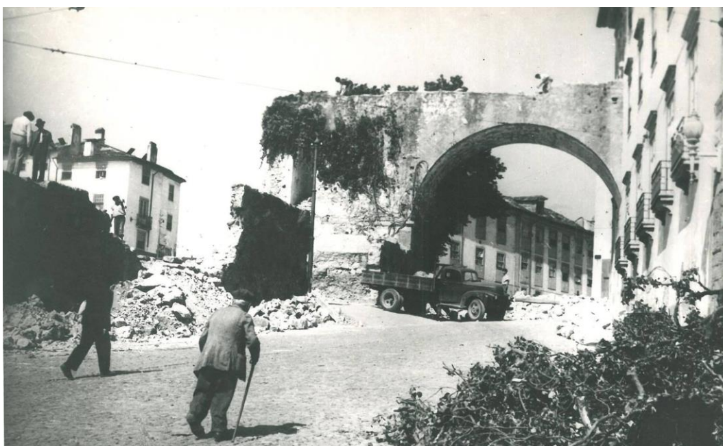
8./Ilustração 18: Imagem da demolição, nos anos quarenta do séc. XX, dos últimos troços de muro do castelo, ainda estando de pé o “arco do Senhor do Castelo”. Imagem gentilmente cedida por Jorge Oliveira.
