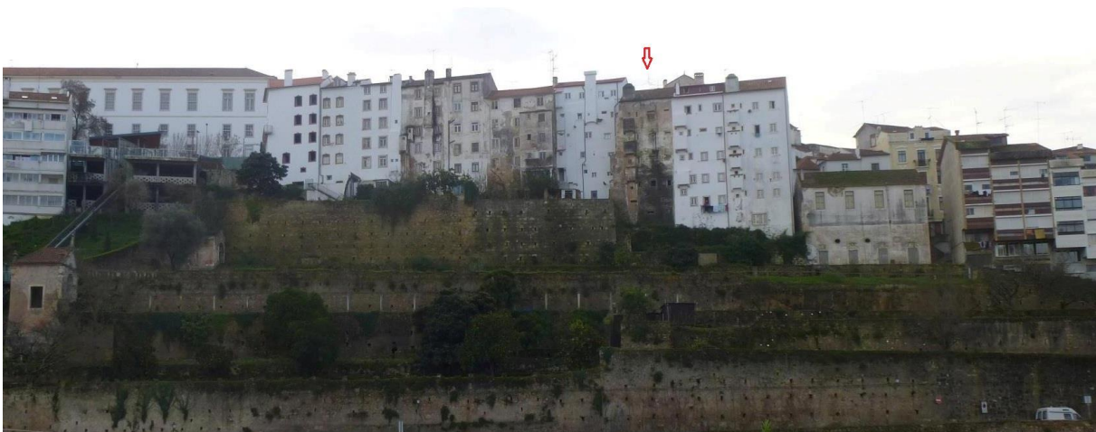
6./Ilustração 287: Fachadas posteriores dos edifícios das ruas de Padre António Vieira e da Couraça dos Apóstolos, onde se encontra assinalado, por uma seta a vermelho, o edifício com o nº 15-17 da couraça dos Apóstolos. Fotografia da autoria de Jorge Ferreira, de 6 de Janeiro de 2013.
