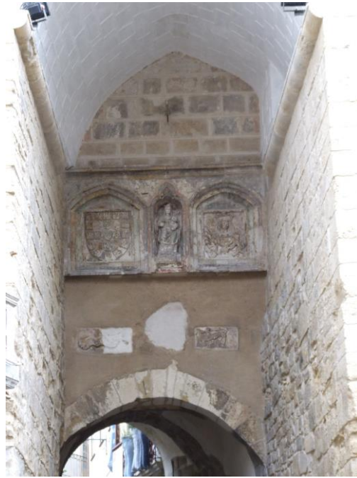
6./Ilustração 15: A fachada que precede a passagem na porta de Almedina ostenta algumas assimetrias que poderão indicar pré-existências que impediram uma solução esteticamente mais perfeita: o friso que encima as paredes laterais não está, nos dois lados, à mesma altura; a abóbada que precede a porta não é simétrica; há um elemento saliente na mesma abóbada, do lado. Fotografia, de 25 de Setembro de 2012, da autoria de Jorge Coelho.
