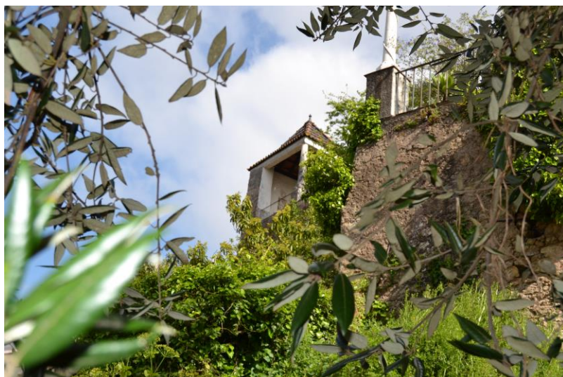
6./Ilustração 197: Fotografia do muro de suporte do logradouro da casa com o nº 6 da couraça de Lisboa, vendo-se atrás o torreão da muralha, já sobre a barbacã. Fotografia da autoria de Jorge Ferreira, de 11 de Julho de 2013.
