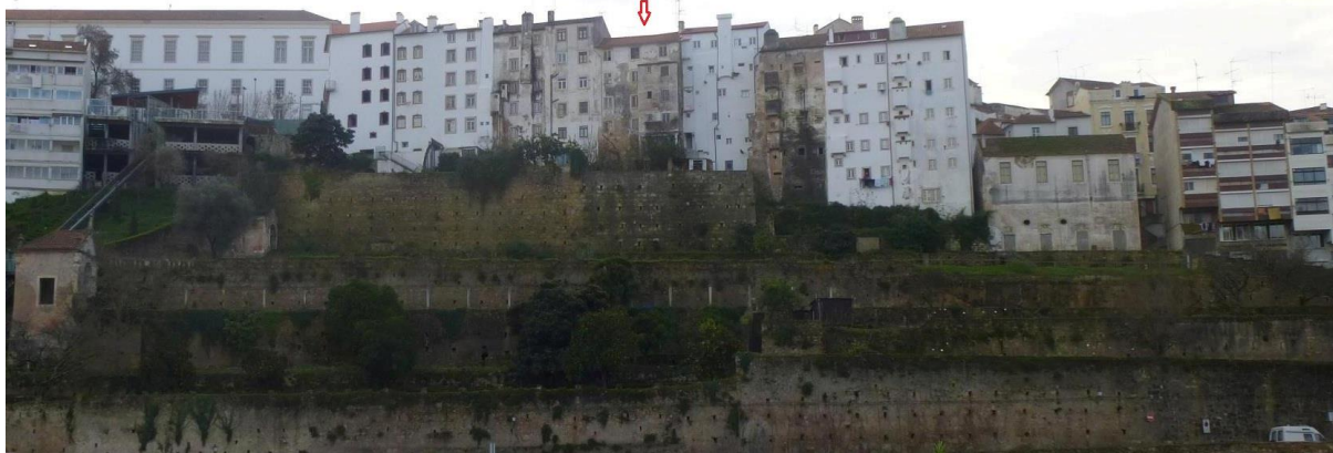
6./Ilustração 282: Fachadas posteriores dos edifícios das ruas de Padre António Vieira e da Couraça dos Apóstolos, onde se encontra assinalado, por uma seta a vermelho, o edifício com o nº 25-29 da couraça dos Apóstolos. Fotografia da autoria de Jorge Ferreira, de 6 de Janeiro de 2013.
