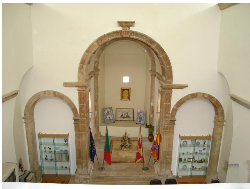
6./Ilustração 64: Na edificação da igreja do colégio de Santo António da Estrela as paredes laterais tiveram de ser cortadas para permitir a inserção da cabeceira, situação que não aconteceria se as paredes tivessem sido edificadas de raiz. Fotografia da autora, de 24 de Julho de 2008.
