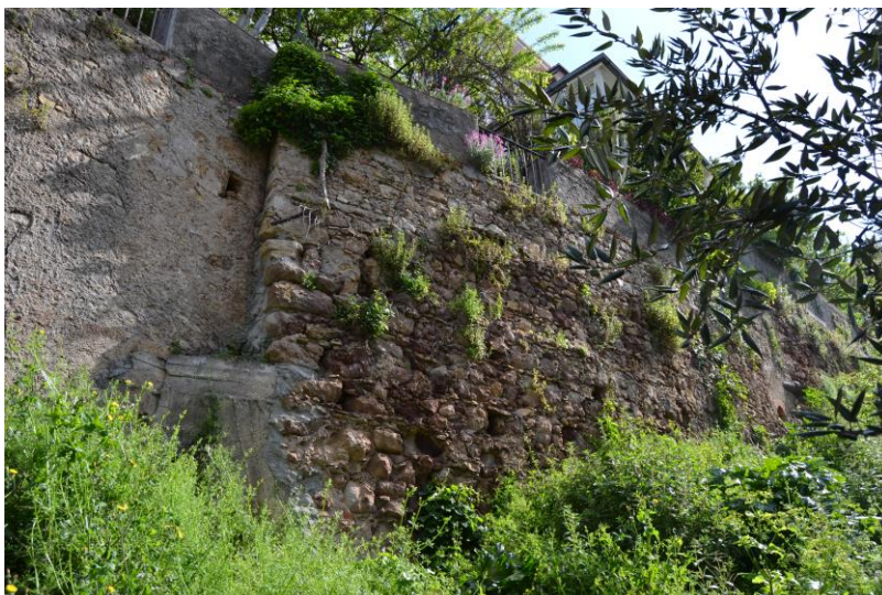
6./Ilustração 196: Fotografia de muros de suporte dos logradouros das casas com os nº 12/14, nº 8/10 e nº 6 da couraça de Lisboa. Fotografia da autoria de Jorge Ferreira, de 11 de Julho de 2013.
