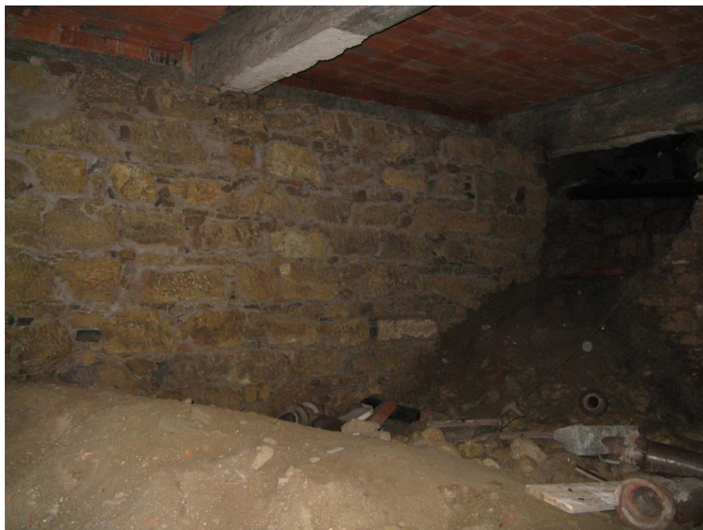
6./Ilustração 264: Muro existente sob o edifício do nº 62 da rua de Padre António Vieira. Fotografia da autoria de Sérgio Madeira, de 16 de Julho de 2010.
