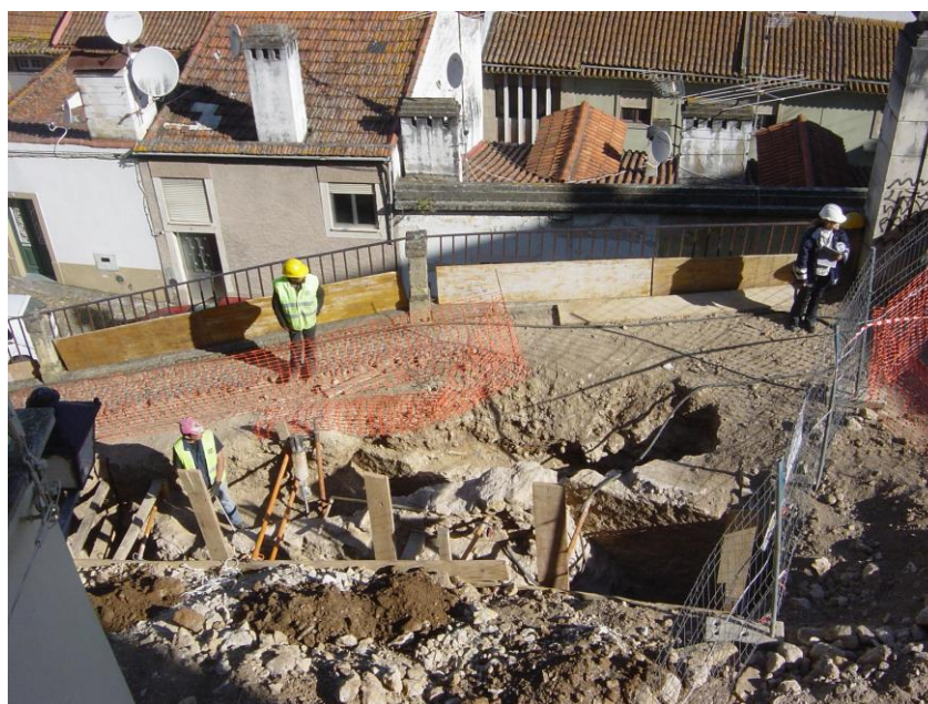
6./Ilustração 356: Troço da estrutura defensiva da cidade e de um muro da cerca do colégio Novo, descobertos durante uma campanha arqueológica, em 2010. Fotografia da autora, de 4 de Maio de 2010, aqui inserida com autorização do arqueólogo responsável, o Dr. Sérgio Madeira.
