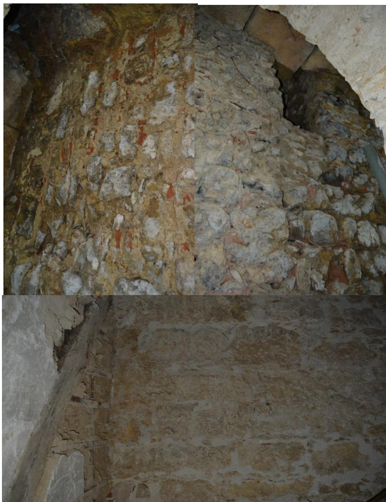
6./Ilustração 52: Pormenor de aparelhos de muros do edifício localizado na rua do Quebra Costas nº 13 a 19. Fotografia da autoria de Jorge Ferreira, de 26 de Dezembro de 2013.
