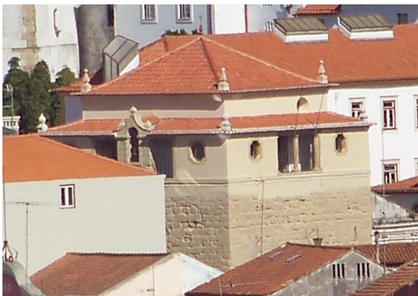
6./Ilustração 42: Fachada sul da Torre da Relação. Extracto de 28 de Outubro de 2012, da autoria de Jorge Ferreira.
