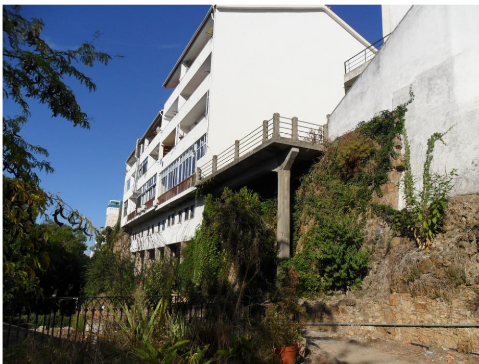
6./Ilustração 170: Fotografia do edifício que se segue para poente, o nº 30 da couraça de Lisboa (onde existe o café Couraça), cuja cave está parcialmente suspensa sobre a fortificação. Fotografia da autora, de 1 de Outubro de 2010.
