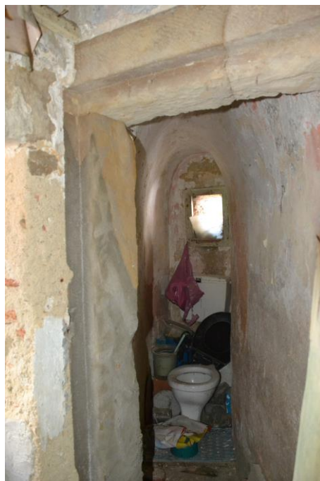
6./Ilustração 289: As mesmas “guaritas”, pelo interior, no canto nordeste do edifício com o nº15-17 da rua da Couraça dos Apóstolos. Fotografia da autoria de Jorge Ferreira, de 20 de Junho de 2013. A padieira da porta é um reaproveitamento de um silhar.
