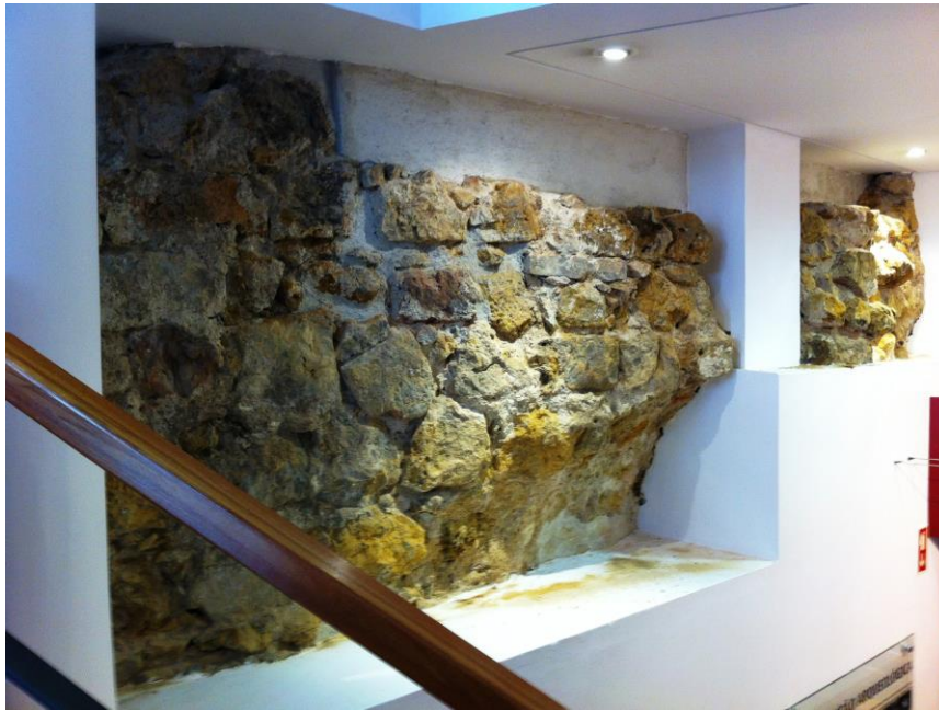
6./Ilustração 34 Base de torre (cubelo) que ladeava o arco da barbacã de Almedina a sul, descoberta em 2005 nas obras de remodelação da livraria Coimbra Editora, na rua Ferreira Borges. É possível ver o arranque de um arco que devia integrar um dos edifícios contíguos à torre a sul. Fotografia, de 10 de Novembro de 2013, da autoria de Jorge Oliveira.
