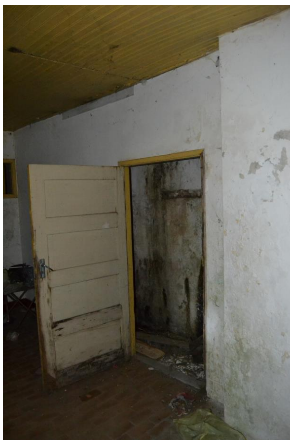
6./Ilustração 305: Porta de acesso ao entrepiso, a partir do piso térreo, do edifício com o nº 1-3 da rua da Couraça dos Apóstolos, inserido na cerca do Colégio Novo. À direita visualiza-se o maciço correspondente à reentrância que assinei nas ilustrações 303 e 304. Fotografia da autoria de Jorge Ferreira, de 30 de Dezembro de 2013.
