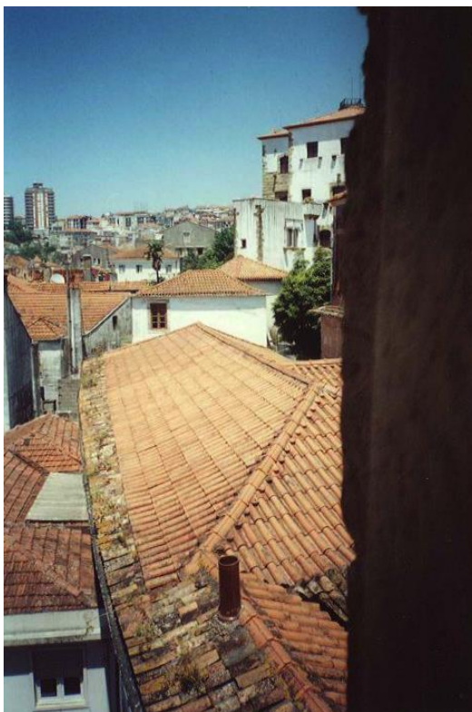
6./Ilustração 21: Foto tirada da Torre da Relação. Ao fundo, junto à árvore, localizam-se as escadas da fotografia anterior. Em primeiro plano podemos ver o adarve, cuja largura está patente no troço de telhado que se vê junto à Torre, e que continuaria no mesmo alinhamento, coincidindo com a parede da escola de Almedina (ver figura seguinte). Fotografia, de 2003, da Dr. a Paula França.
