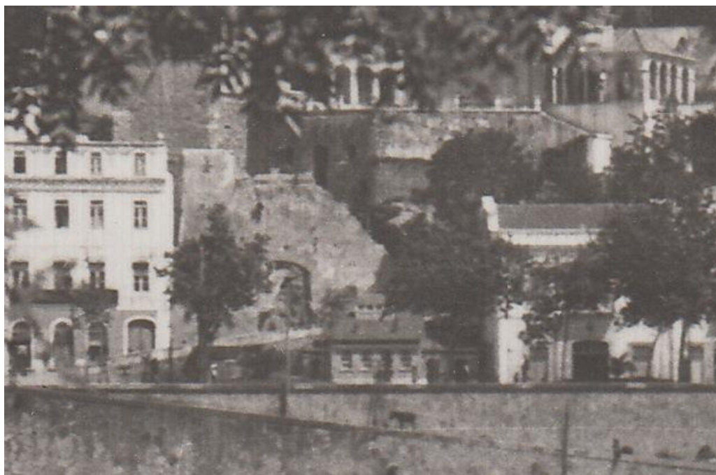
6./Ilustração 123: Extracto de fotografia da década de trinta do séc. XX (gentilmente cedida por António de Paiva Germano) onde se pode visualizar o começo da construção do consultório e garagem do Dr.º Ângelo Rodrigues da Fonseca, no fundo da couraça. Junto à Portagem, visualiza-se uma abertura que suponho corresponder a uma antiga entrada na barbacã. Nesta altura a intervenção na casa já se encontrava concluída.
