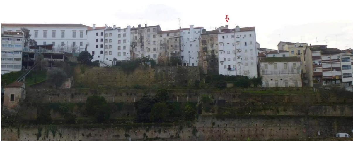
6./Ilustração 299: Fachadas posteriores dos edifícios das ruas de Padre António Vieira e da Couraça dos Apóstolos, onde se encontra assinalado, por uma seta a vermelho, o edifício com o nº 11 da couraça dos Apóstolos. Fotografia da autoria de Jorge Ferreira, de 6 de Janeiro de 2013.
