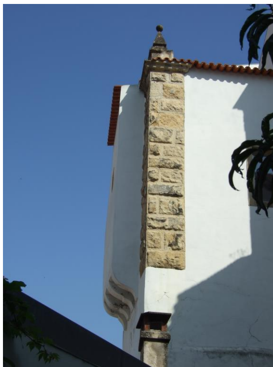
6./Ilustração 63: Torre sobre a barbã aproveitada na cabeira da igreja do antigo colégio de Santo António da Estrela. Fotografia, de 21 de Setembro de 2007, da autoria de Jorge Coelho.
