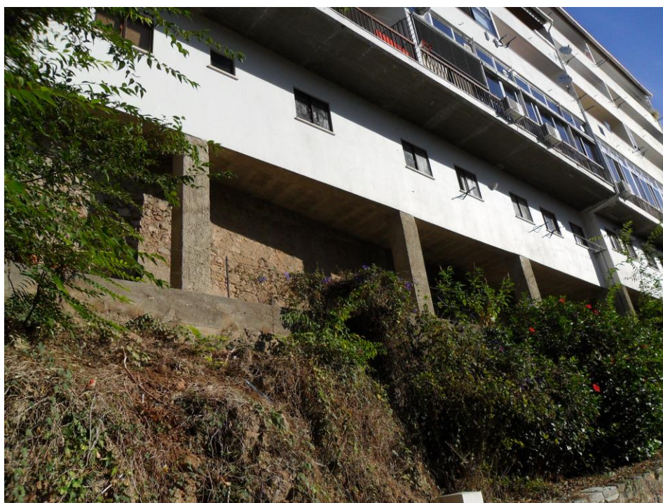
6./Ilustração 175: A torre sob o nº 30 da couraça de Lisboa. Fotografia da autoria de Jorge Ferreira, de 11 de Julho de 2013.
