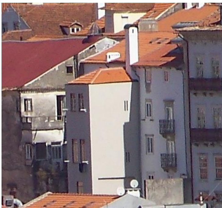
6./Ilustração 94: Segunda torre a norte da Torre quinária da Estrela, sobre a barbacã. Extracto de fotografia da autoria de Jorge Ferreira, de 15 de Outubro de 2012.
