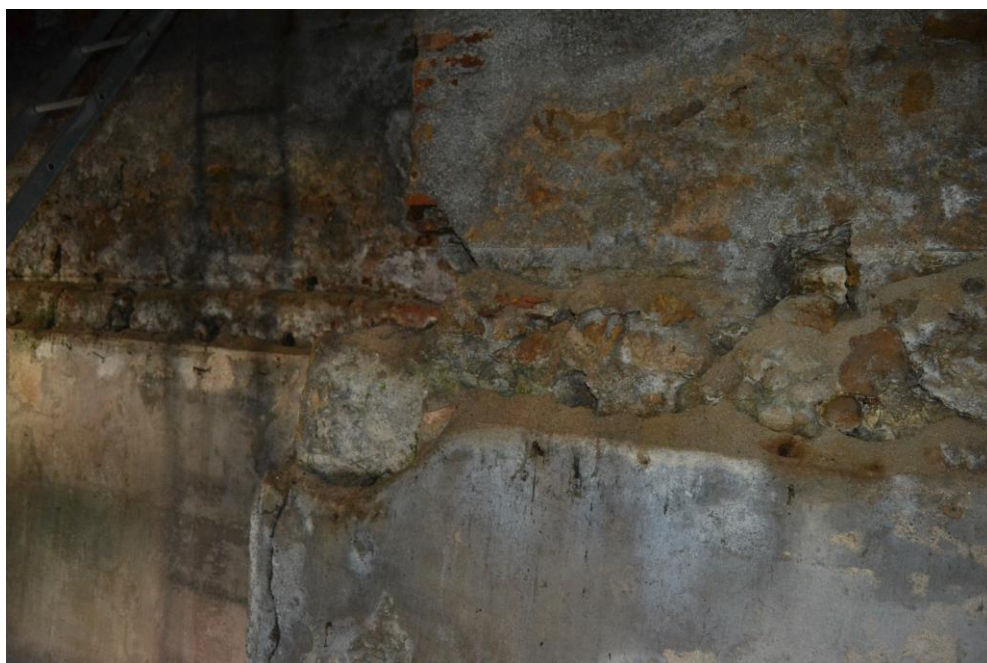
6./Ilustração 308: Pormenor do cunhal da saliência na base do maciço (referido nas ilustrações 305, 306 e 307), no canto sudoeste no entrepiso do edifício com o nº 1-3 da rua da Couraça dos Apóstolos, inserido na cerca do Colégio Novo. Fotografia da autoria de Jorge Ferreira, de 30 de Dezembro de 2013.
