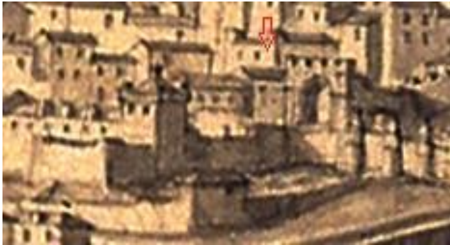
6./Ilustração 127: A torre do Engenho, assinalada por uma seta a vermelho, em imagem de Pier Maria Baldi, de 1669. Extracto de uma imagem pertencente à Biblioteca Medicea Laurenziana , Florença, Itália, Inv. N° 142 bis del ms. Laur. Med. Palat. 123/1.
