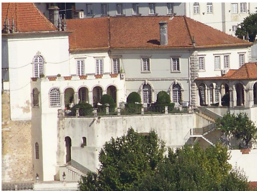
6./Ilustração 70: Fotografia do jardim do poço do edifício do Governo Civil, sobre a cisterna do antigo Colégio da Estrela e que poderá corresponder a uma antiga casamata. Fotografia da autoria de Jorge Ferreira, de 15 de Outubro de 2012.
