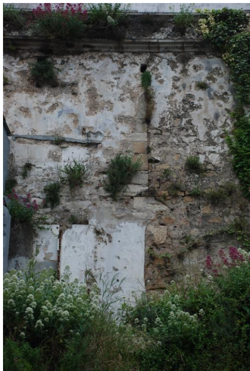
6./Ilustração 325: Pormenor da varanda do Colégio Novo, onde se pode observar um cunhal, possivelmente de uma antiga torre. Fotografia da autoria de Jorge Ferreira, de 14 de Maio de 2013.
