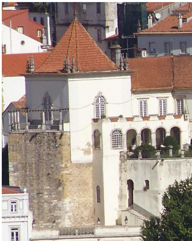
6./Ilustração 67: Fotografia actual da torre quinária da Estrela. Extracto de fotografia da autoria de Jorge Ferreira, de 15 de Outubro de 2012.
