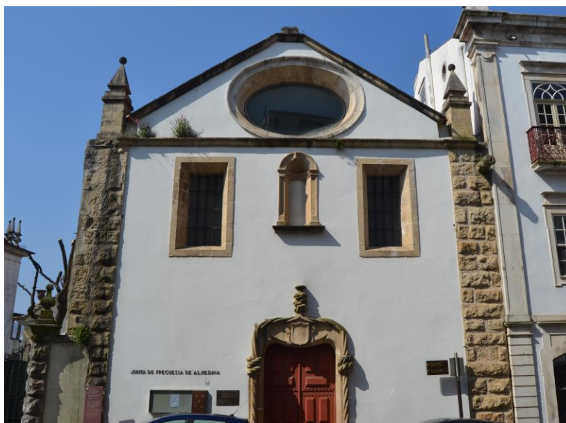
6./Ilustração 135: Fotografia da fachada da antiga igreja do colégio de Santo António da Estrela, anteriormente sede da junta de freguesia de Al medina, onde se nota a assimetria dos elementos que a constituem. Fotografia da autoria de Jorge Ferreira, de 31 de Março de 2014.
