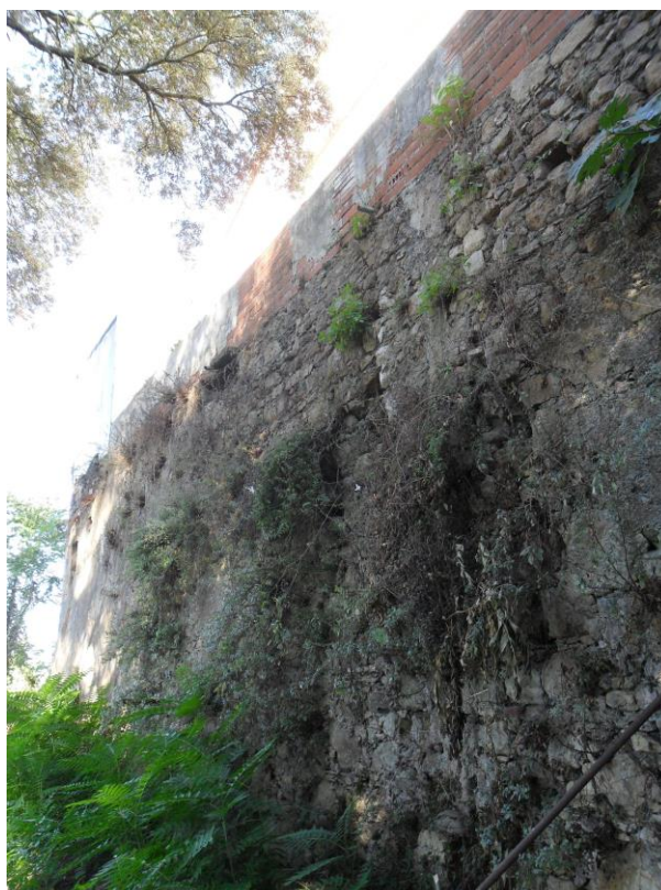
6./Ilustração 187: Talvez este edificado possa corresponder a antigas construções sobre a barbacã, possivelmente por iniciativa dos frades do colégio de S. Bento. Fotografia da autora, de 1 de Outubro de 2010.
