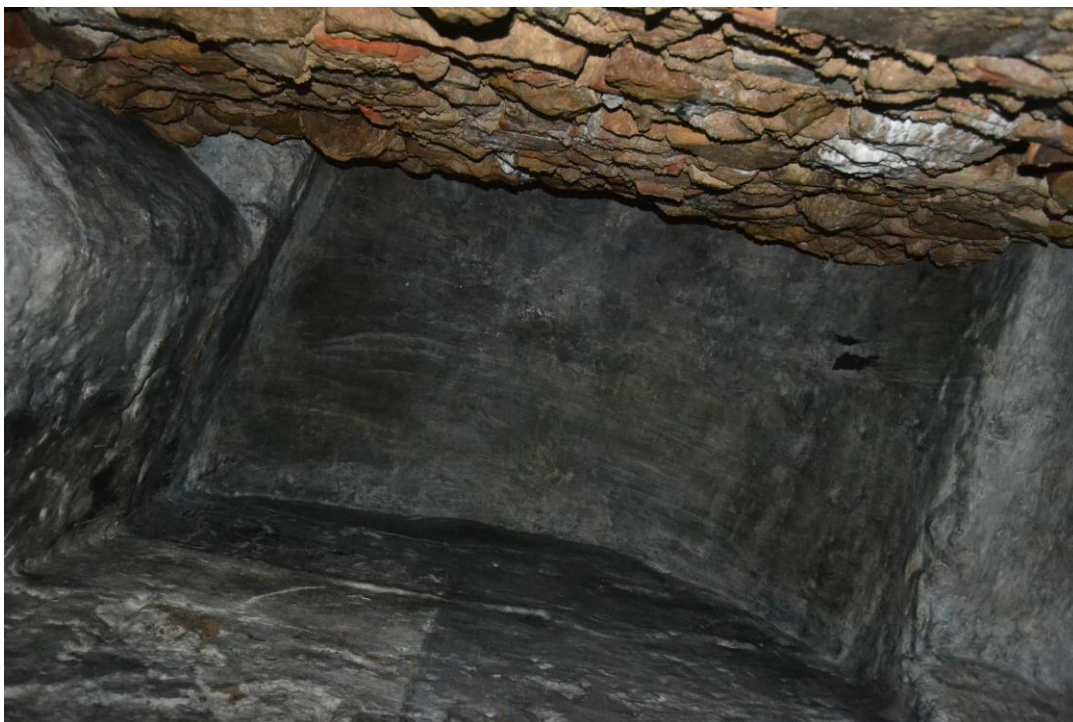
6./Ilustração 7: Abóbada do vão, em arco, da passagem sob o que penso ter sido uma anterior torre, onde se vê o tímpano em pedra, talvez inacabado, que apresenta uma marcação circular. Fotografia da autoria de Jorge Ferreira, de 31 de Março de 2014, gentilmente autorizada (assim como a sua introdução neste trabalho) pela arqueóloga responsável, a Dr.ª Susana Temudo.
