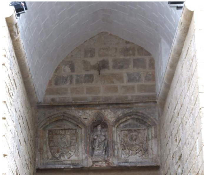
6./Ilustração 16: O friso que encima as paredes laterais não está, nos dois lados, à mesma altura, e a abóbada que precede a porta de Almedina não é simétrica. Extracto da fotografia, de 25 de Setembro de 2012, da autoria de Jorge Coelho.
