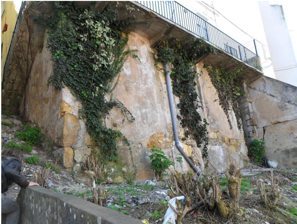
6./Ilustração 267: Torre existente sob o edifício com o nº 56 da rua de Padre António Vieira. Fotografia da autora, de 8 de Março de 2012.
