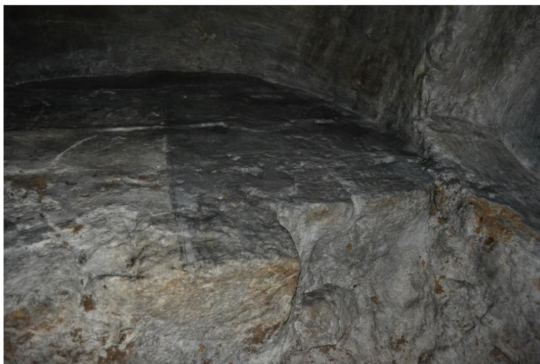
6./Ilustração 8: Marcação circular (em forma de arco ultrapassado?) no tímpano em pedra, talvez inacabado, do vão, em arco, da passagem sob o que penso ter sido uma anterior torre. Fotografia da autoria de Jorge Ferreira, de 31 de Março de 2014, gentilmente autorizada (assim como a sua introdução neste trabalho) pela arqueóloga responsável, a Dr.ª Susana Temudo.
