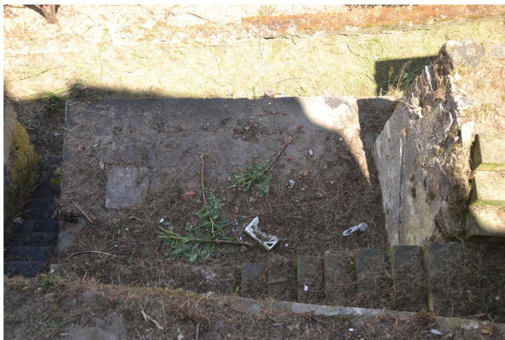
6./Ilustração 297: O patamar da cisterna, visualizando-se a tampa da entrada, encostado pelo exterior à parede norte do edifício, fotografado a partir do interior do edifício com o nº 15-17 da rua da Couraça dos Apóstolos. Fotografia da autoria de Jorge Ferreira, de 11 de Julho de 2013.
