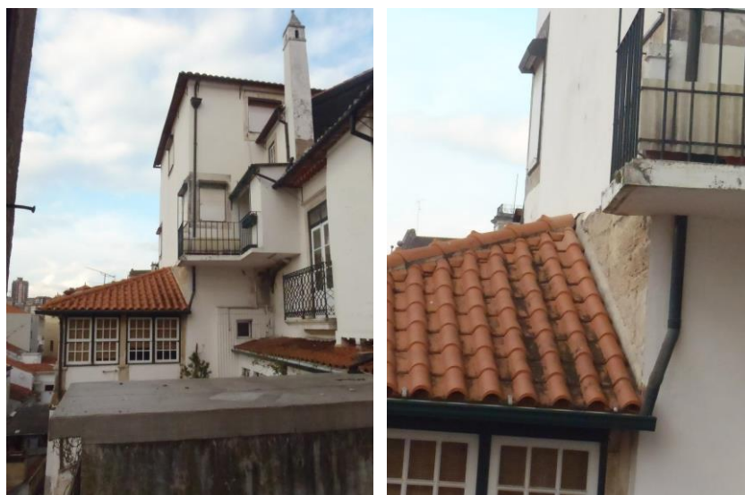
6./Ilustração 99: As traseiras do edifício do nº 52, da rua de Fernandes Tomás (antiga rua das Fangas), onde se podem visualizar a quarta e a quinta torres a norte da Torre quinária da Estrela (a primeira é da barbacã e a segunda é da muralha). É possível visualizar o aparelho da torre sob o reboco. Fotografias da autoria de Augusto Pestana, de 1 de Março de 2013.
