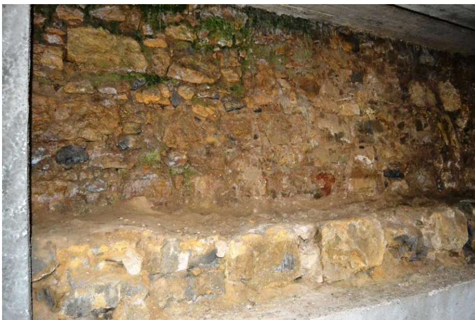
6./Ilustração 260: Muros existentes, sob o elevador do mercado, na rua de Padre António Vieira. Fotografia da autoria de Jorge Ferreira, de 14 de Dezembro de 2012.
