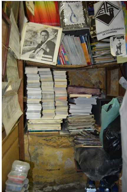
6./Ilustração 31: Reentrância existente na livraria alfarrabista que poderá corresponder a uma antiga porta e que parece sair do alinhamento do perímetro das paredes exteriores da Torre, e coincidir com o perímetro da torre mais antiga, que creio existir. Fotografia, de 12 de Novembro de 2013, da autoria de Jorge Ferreira.
