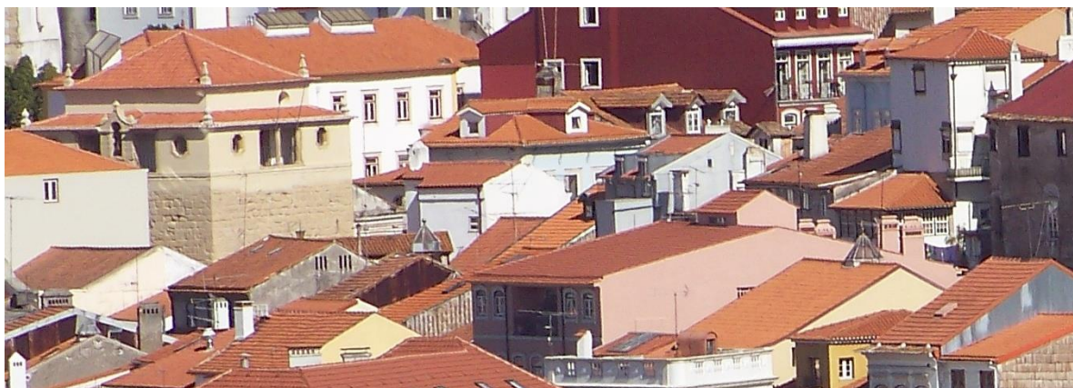
6./Ilustração 104: Entre a Torre da Relação à esquerda e as torres do nº 52 da rua de Fernandes Tomás (antiga rua das Fangas) parecem ter existido mais uma ou duas torres, aproximadamente onde se encontra o edifício azul, recentemente intervencionado, seriam a sexta e a sétima torres a norte da Torre quinária da Estrela, respectivamente da barbacã e da muralha. Extracto de fotografia da autoria de Jorge Ferreira, de 15 de Outubro de 2012.
