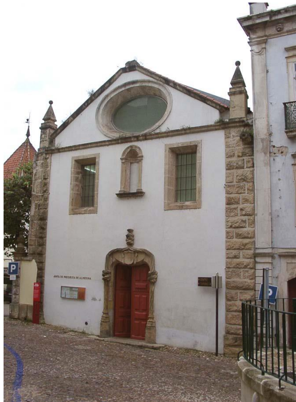
6./Ilustração 65: Porta do edifício da antiga igreja do colégio de Santo António da Estrela que, afinal, sempre se manteve no mesmo local. De facto, não está centrada mas deslocada cerca de 0.55m, para a direita, o que originou que o nicho que se lhe sobrepõe também não ficasse centrado na fachada, nem com a porta. Terá sido certamente ainda mais complicado posicionar o óculo, de modo que aparentasse centralidade, já que a sua proximidade às águas do telhado acentuavam o erro. Fotografia da autora, de 24 de Julho de 2008.
