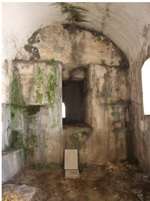
6./Ilustração 115: Vista da parede sul da “casa de fresco”, contígua à cisterna do antigo colégio de Santo António da Estrela, provavelmente correspondente a uma antiga casamata. Fotografia da autoria de Jorge Coelho, de 12 de Fevereiro 2007.
