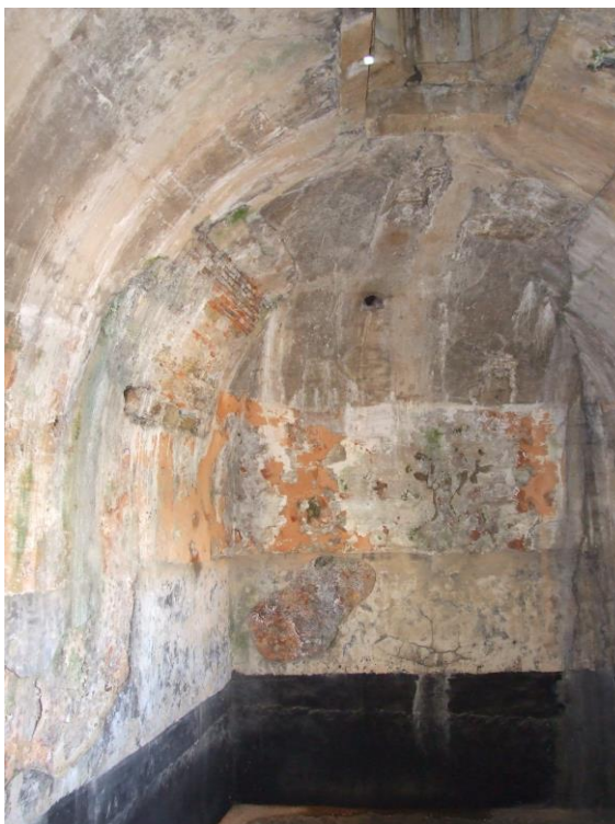
6./Ilustração 74: Fotografia da cisterna do antigo colégio de Santo António da Estrela, onde se pode visualizar uma abertura entaipada na parede nascente, ao cimo, à esquerda. Fotografia da autoria de Jorge Coelho, de 21 de Setembro de 2007.
