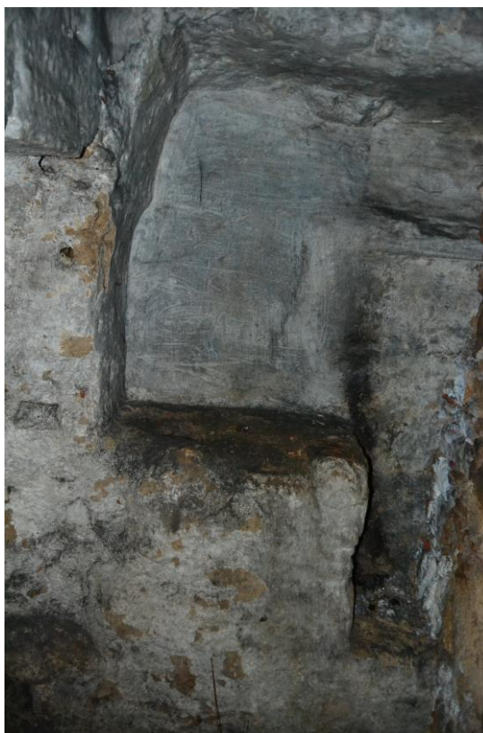
6./Ilustração 10: Nicho existente do lado nascente do vão, em arco, da passagem sob o que penso ter sido uma anterior torre. Fotografia da autoria de Jorge Ferreira, de 31 de Março de 2014, gentilmente autorizada (assim como a sua introdução neste trabalho) pela arqueóloga responsável, a Dr.ª Susana Temudo.
