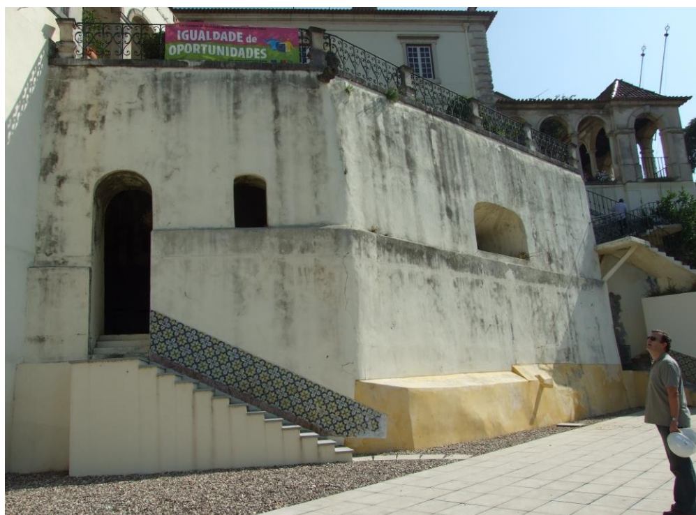
6./Ilustração 122: Vista dos vãos da antiga casamata sob o edifício do antigo Governo Civil. O vão correspondente à cisterna, mais a sul, encontra-se diminuído na sua altura, ao contrário do correspondente à entrada da casa de fresco que terá sido rasgado, fazendo-se o acesso a esta talvez por um vão onde hoje se encontra o elevador, do lado esquerdo da fotografia. Estas diferenças percebem-se por comparação com a fotografia anterior (ilustração 121). Fotografia da autoria de Jorge Coelho, de 12 de Fevereiro 2007.
