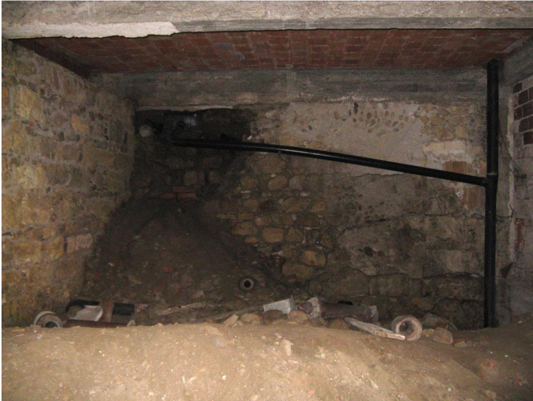
6./Ilustração 263: Muro existente sob o edifício do nº 62 da rua de Padre António Vieira. Fotografia da autoria de Sérgio Madeira, de 16 de Julho de 2010.
