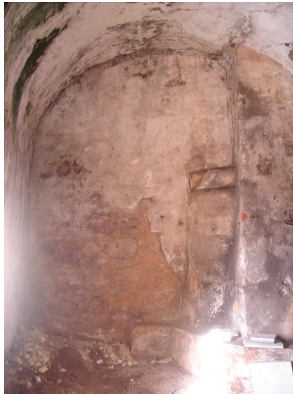
6./Ilustração 118: Vista da parede norte do interior da casa de fresco do antigo colégio de Santo António da Estrela, onde se visualiza uma parede entaipada, do lado contrário ao da entrada na cisterna, provavelmente para permitir a instalação de um elevador, de acesso da casa ao consultório e garagem do Dr.º Ângelo da Fonseca e que ainda hoje lá existe. Fotografia da autoria de Jorge Coelho, de 12 de Fevereiro 2007.
