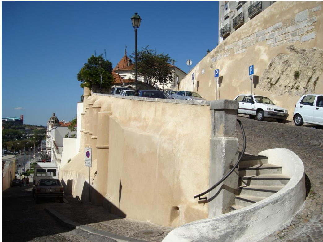
6./Ilustração 136: Fotografia onde se podem ver os contrafortes cilíndricos da couraça manuelina Fotografia da autora, de 13 de Outubro de 2007.
