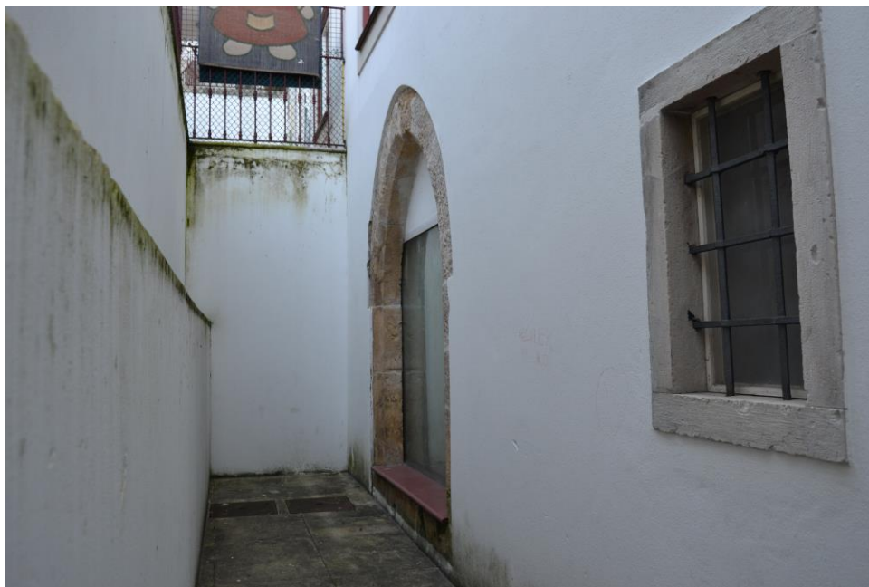
6./Ilustração 19: Entrada para um dos edifícios onde está instalada a escola de Almedina. A cota de soleira está cerca de um piso abaixo da cota do pátio (contíguo) da escola. Fotografia, de 24 de Novembro de 2012, da autoria de Jorge Ferreira.
