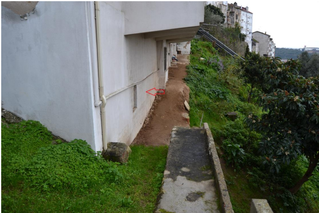
6./Ilustração 262: Edifício com o nº 62 da rua de Padre António Vieira, onde existe uma pequena abertura (assinalada por uma seta a vermelho), dentro da qual existe um muro que poderá ter pertencido a uma fortificação. Fotografia da autoria de Jorge Ferreira, de 7 de Dezembro de 2012.
