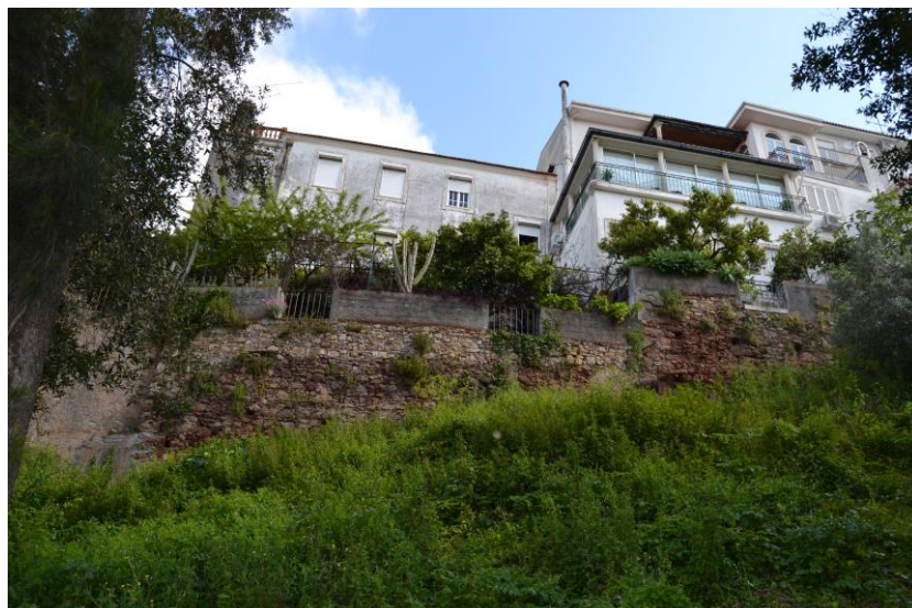
6./Ilustração 194: Fotografia de muros de suporte dos logradouros das casas com os nº 12/14, nº 8/10 e nº 6 da couraça de Lisboa. Fotografia da autoria de Jorge Ferreira, de 11 de Julho de 2013.
