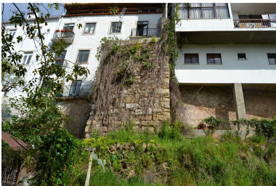
6./Ilustração 179: Torre existente imediatamente a poente do nº 30, já no alinhamento do edifício com o nº 22. Fotografia da autoria de Jorge Ferreira, de 11 de Julho de 2013.
