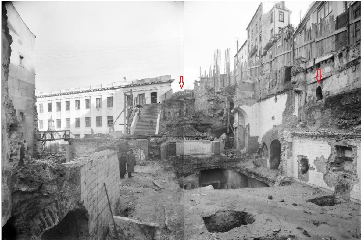
6./Ilustração 332: Fotografias de Domingos Alvão, da colecção da autora, referentes à demolição das cozinhas do mosteiro de Santa Cruz. Encontram-se assinalados, com uma seta a vermelho, o que parece ser uma conduta de água e um muro (com grande espessura) a nascente daquela.
