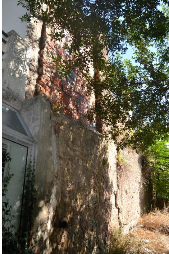
6./Ilustração 236: Continuação do alinhamento do maciço redondo sobre o qual assenta um pavimento de madeira de uma varanda do edifício do piso mais baixo, em cave, do Instituto de Justiça e Paz. Fotografia da autoria de Jorge Ferreira, de 16 de Setembro de 2013.
