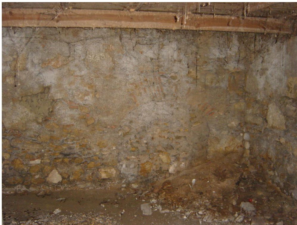
6./Ilustração 296: Vão em arco, entaipado e semi-enterrado, na parede poente do edifício com o nº 15-17 da rua da Couraça dos Apóstolos. Fotografia da autora, de 4 de Maio de 2010.
