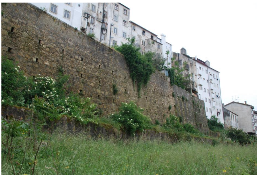
6./Ilustração 361: Paredão de sustentação de quintais nas traseiras da rua da Couraça dos Apóstolos. Fotografia da autoria de Jorge Ferreira, de 11 de Julho de 2013.
