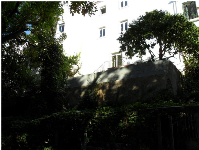
6./Ilustração 183: Muros de suporte de terras no alinhamento do edifício nº 18/20 da couraça de Lisboa. Fotografia da autora, de 1 de Outubro de 2010.
