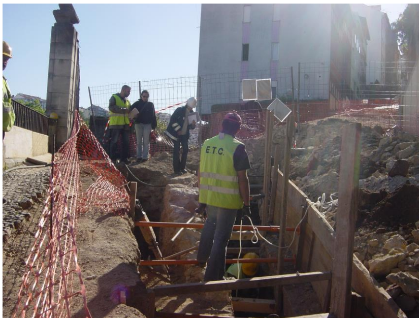
6./Ilustração 355: Troço da estrutura defensiva da cidade e de um muro da cerca do colégio Novo, descobertos durante uma campanha arqueológica, em 2010. Fotografia da autora, de 4 de Maio de 2010, aqui inserida com autorização do arqueólogo responsável, o Dr. Sérgio Madeira.
