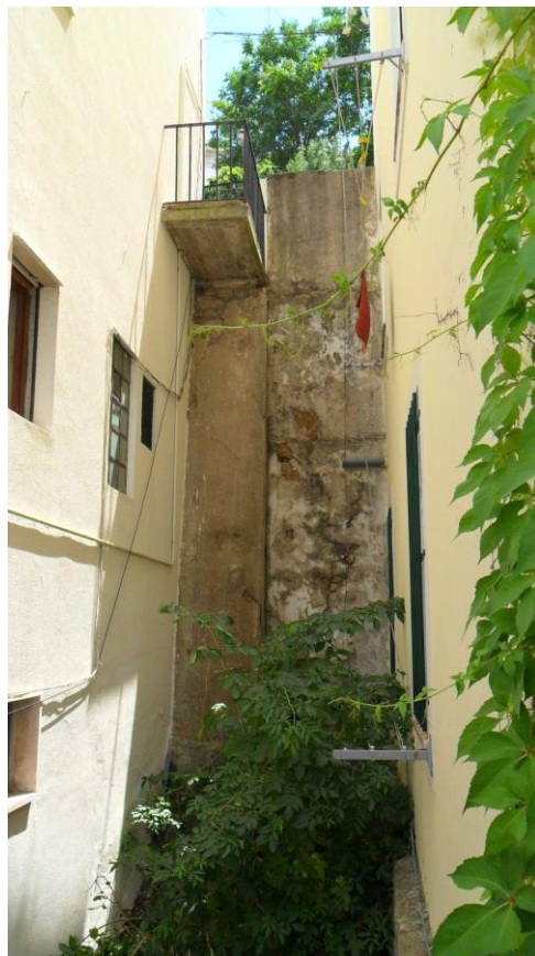
6./Ilustração 268: Muro a sul entre o edifício com o nº 56 da rua de Padre António Vieira e o que lhe fica contíguo, a nascente. Fotografia da autora, de 16 de Julho de 2010.
