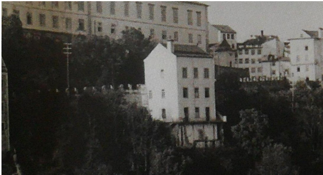
6./Ilustração 272: Extracto de fotografia do edifício com o nº 56 da rua de Padre António Vieira, da primeira metade do séc. XX (gentilmente cedida pela Dr.ª Leonor Cavalheiro, Irmã do proprietário) na qual se visualiza, a sul, o muro, ornado de “ameias”.
