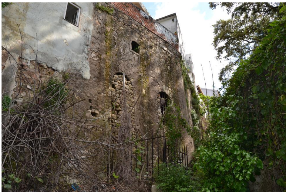
6./Ilustração 188: Edificação sobre a barbacã, possivelmente por iniciativa dos frades do colégio de S. Bento. Fotografia da autoria de Jorge Ferreira, de 11 de Julho de 2013.
