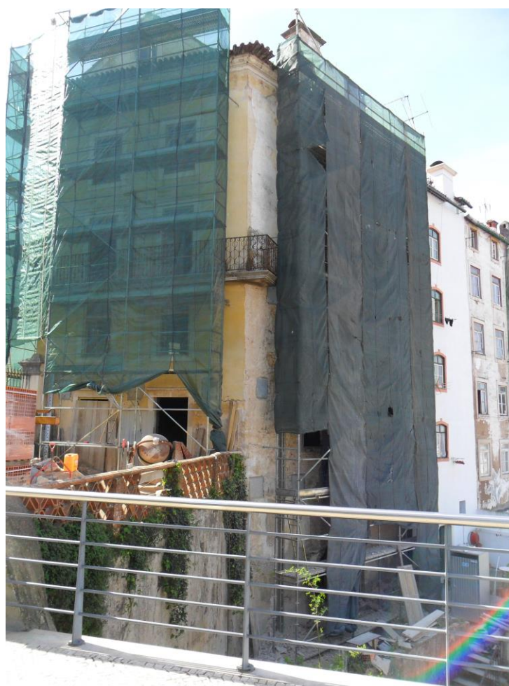
6./Ilustração 258: Fachadas nascente e norte do edifício com o nº 47-49 da couça dos Apóstolos. Fotografia da autora, de 8 de Março de 2012.
