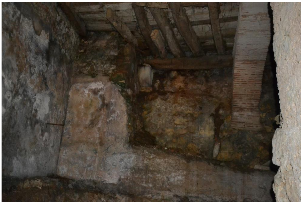
6./Ilustração 293: No canto sudeste do edifício com o nº 15-17 da rua da Couraça dos Apóstolos visualiza-se um vão na parede sul, entaipado e cortado (sem uma das ombreiras). Fotografia da autoria de Jorge Ferreira, de 11 de Julho de 2013.
