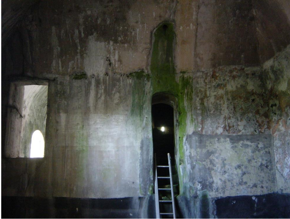
6./Ilustração 117: Vista do interior da cisterna do antigo colégio de Santo António da Estrela. O nível do degrau mais baixo de acesso é sensivelmente o mesmo do espaço contíguo aproveitado para casa de fresco, cuja entrada se visualiza à esquerda. Fotografia da autoria de Jorge Coelho, de 12 de Fevereiro 2007.
