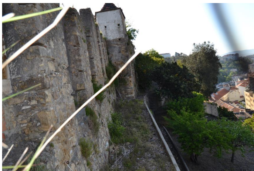
6./Ilustração 202: Fotografia da barbacã na base do torreão do edifício com o n° 2 A da couraça de Lisboa. Fotografia da autoria de Augusto Pestana, de 11 de Julho de 2013.
