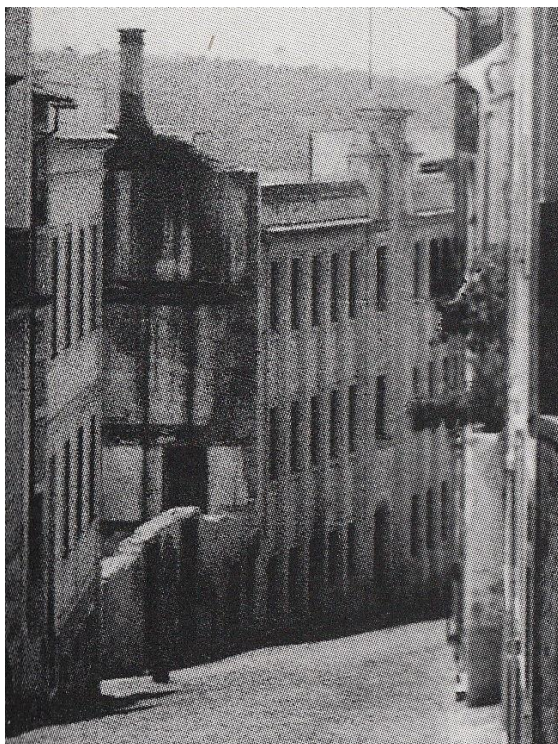
6./Ilustração 228: Fotografia tirada durante as obras da cidade universitária (A velha Alta... desaparecida, 1991, p. 111) onde se vê o novo edifício do Instituto de Justiça e Paz, estando já demolido o edifício contíguo a nascente.
