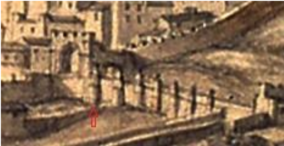
5./Ilustração 27: Esquina sudoeste do elemento que creio poder ser o arco romano, muito próxima do cubelo assinalado (ainda hoje existente) da extremidade poente da couraça manuelina Extracto de uma imagem de Pier Maria Baldi, de 1669, pertencente à Biblioteca Medicea Laurenziana, Florença, Itália, Inv. N° 142 bis del ms. Laur. Med. Palat. 123/1.
