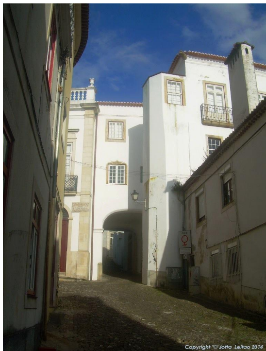
5./Ilustração 72: Elemento arquitectónico, que se destaca na fachada da Casa da Escrita, que poderá corresponder a um antigo cubelo, sito na confluência das ruas do Loureiro e de João Jacinto. Fotografia de Jotta Leitão, de 2014.
