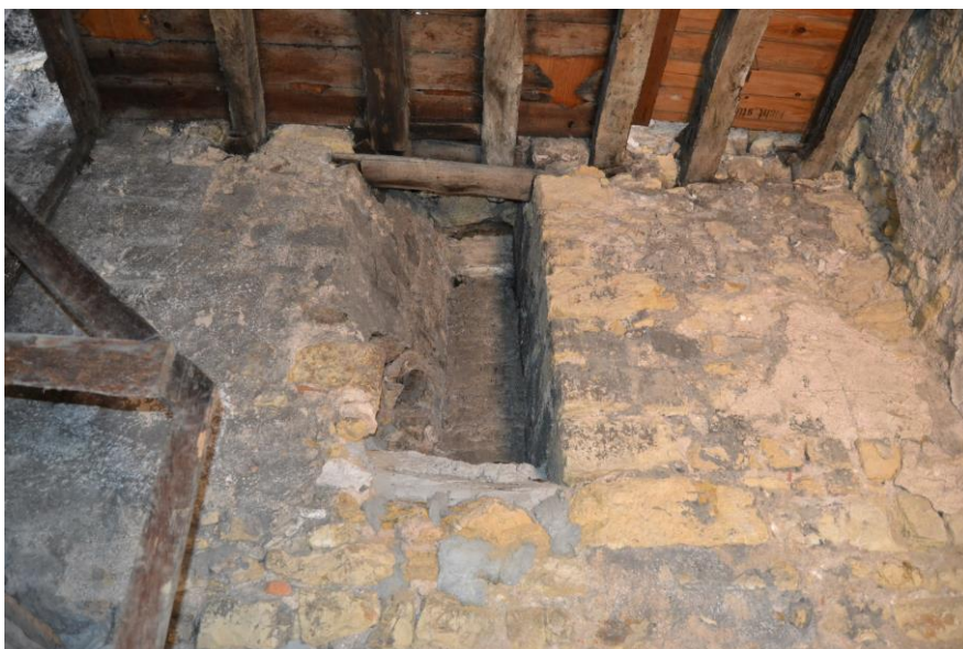
5./Ilustração 78: Perspectiva da subida ao piso mais elevado da torre da igreja do Salvador, onde se pode ver uma antiga abertura na parede nascente. Fotografia de 11 de Julho de 2013, da autoria de Jorge Ferreira.
