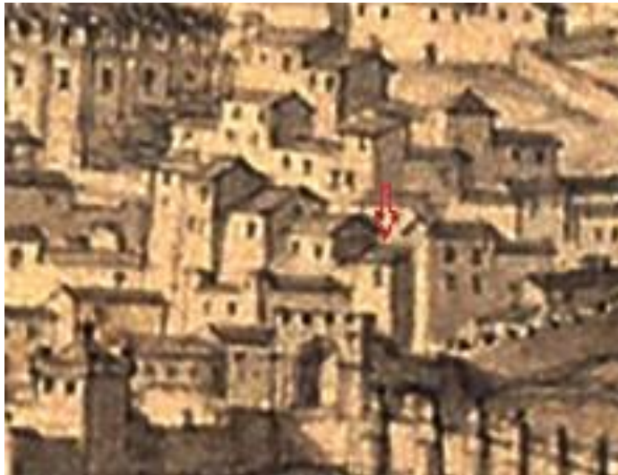
5./Ilustração 13: A torre na esquina de um arruamento hoje transformado em travessa, que terá sido, possivelmente, uma via estruturante em vários períodos da história da cidade. Extracto de uma imagem de Pier Maria Baldi, de 1669, pertencente à Biblioteca Medicea Laurenziana, Florença, Itália, Inv. N° 142 bis del ms. Laur. Med. Palat. 123/1.
