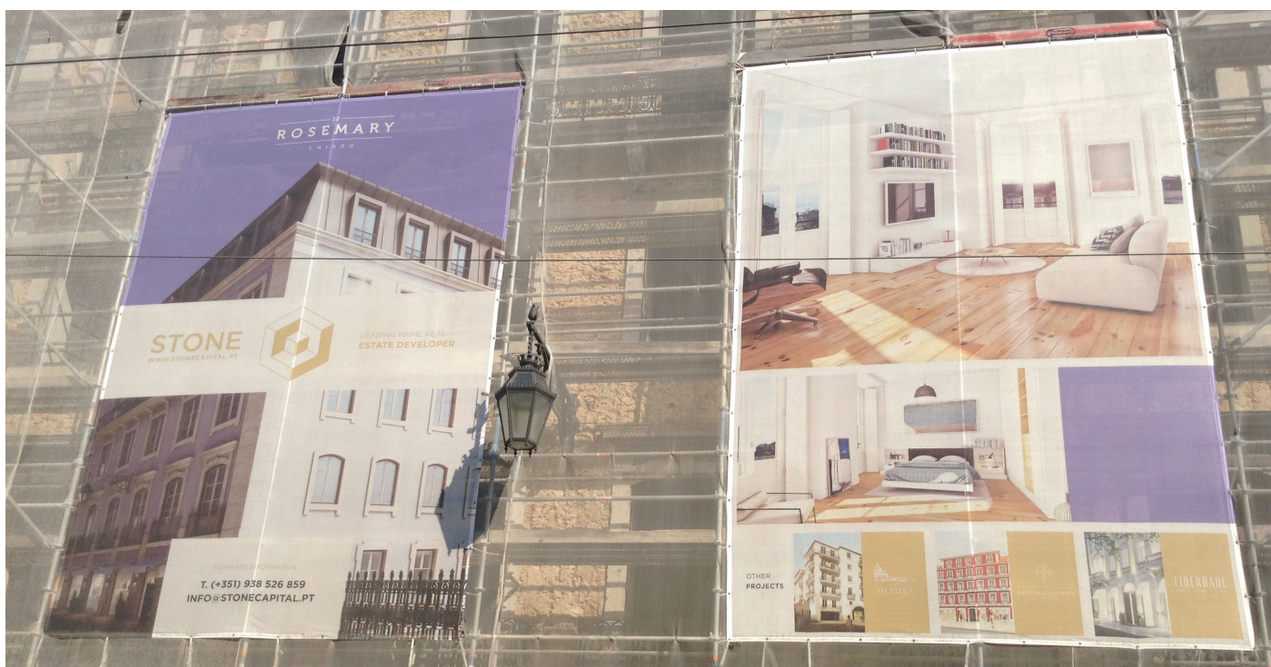
Figura 69. Edifício da Rua Alecrim, com projeto de reabilitação deste ano que optou pelo lilás para a fachada. Fotografia da autora deste trabalho, Setembro 2015
