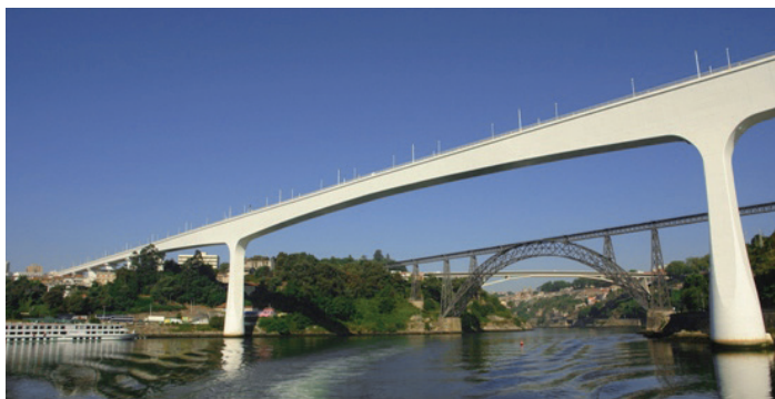
Figura 83. Ponte S. João, 1991, Edgar Cardoso Fotografia, [s.d] (imagem https://pontesvida.wordpress.com/category/dia-a-dia/page/2/ )
