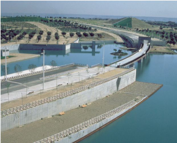
Figura 33. Parque Juan Carlos I Fotografia, [s.d] (imagem http://arqa.com/arquitectura/parque-juan-carlos-i.html# )
