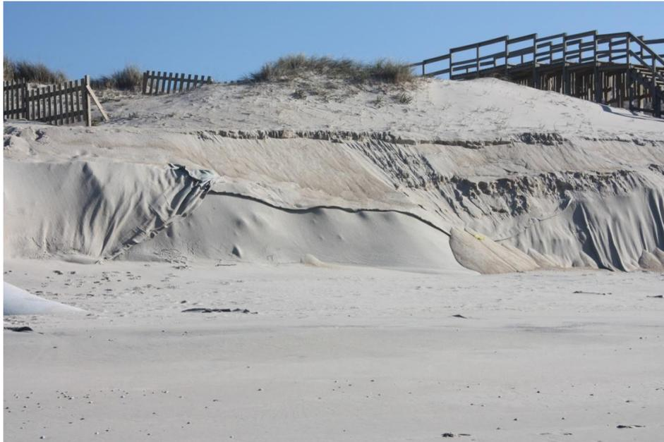
Figura 4. Sistema dunar existente na Leirosa. Neste caso, foram usados geotêxteis no restauro do sistema dunar.
