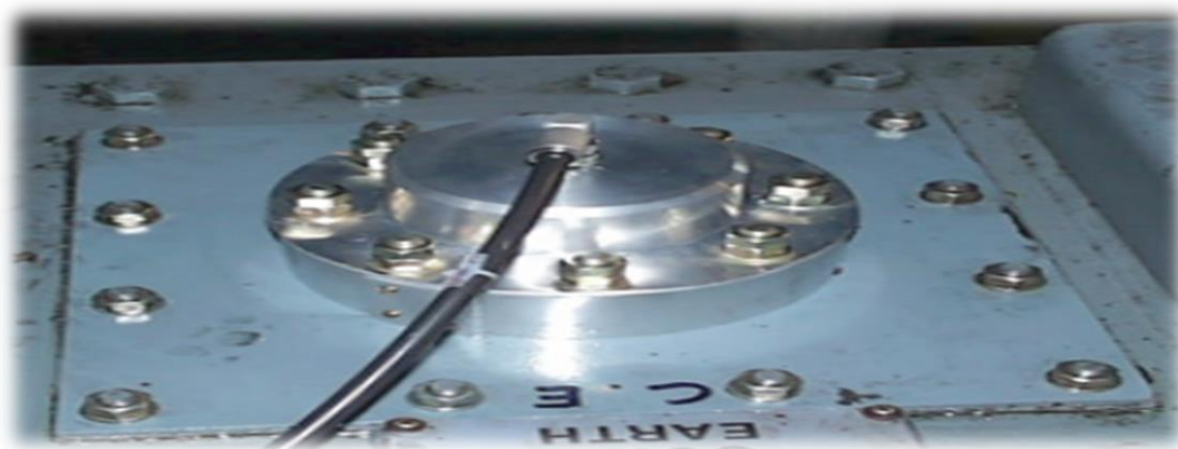
Figura 10 - Inserção de uma antena RF num transformador (Baker, 2010).
