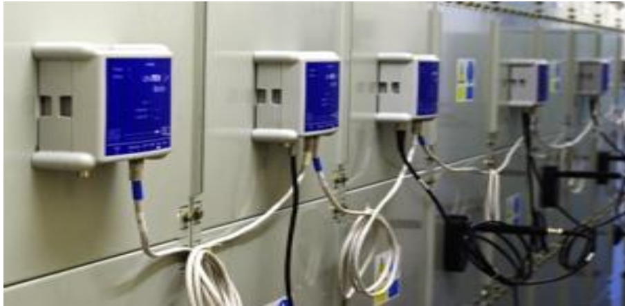
Figura 7-Rede de sensores TEV montados em sistema de comutação nas estações de distribuição de energia eléctrica (EATechnology, 2015).
