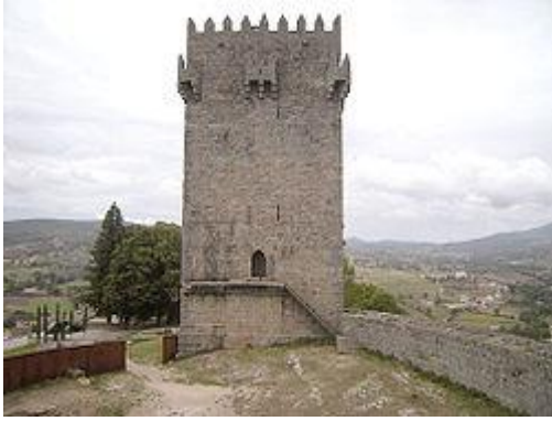
Castelo de Montalegre - Torre de menagem
