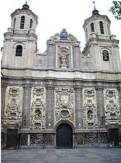
Igreja barroca de Santa Isabel de Portugal (Saragoça)
