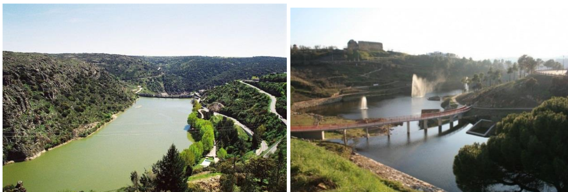
Barragem de Miranda
