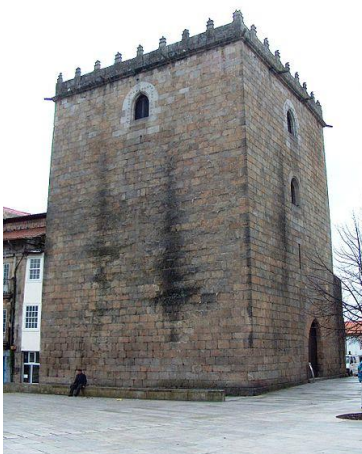
Barcelos Torre da Porta Nova
