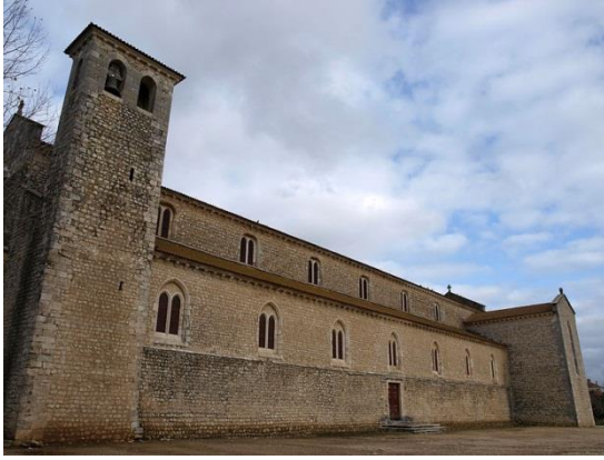
Vista geral da fachada sudeste do Convento de Santa Clara de Santarém
