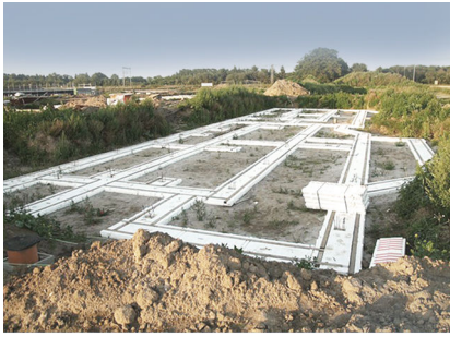
Fig. 103_ Fundações do bloco nº4.
