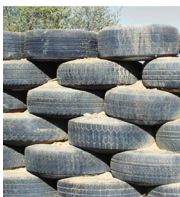
Fig.38_ Construção em parede-pneu. Mértola, Portugal.
