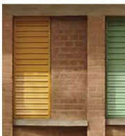
Fig.35_ Construção em blocos de adobe. Gando, Burkina Faso.
