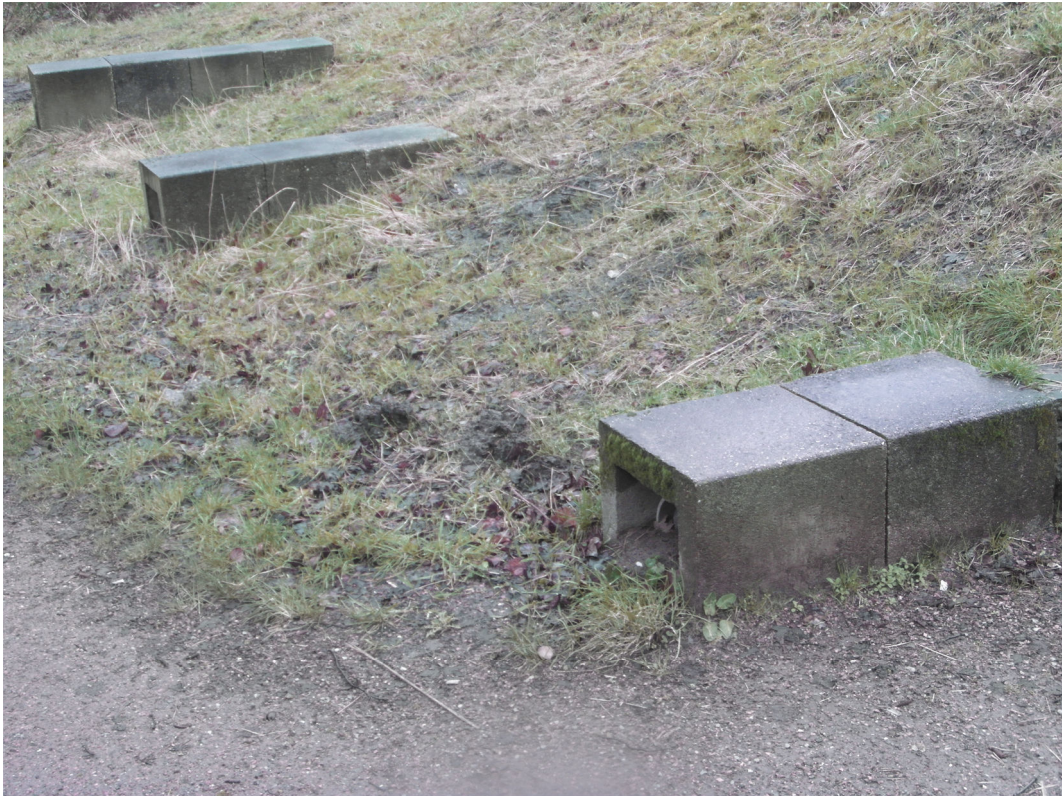
Fig 85_Canais exteriores de entrada do ar para ventilação (a norte).
