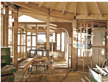
Fig. 106_ Interior em construção.
