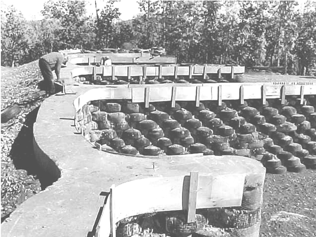
Fig.48_Viga de amarração na parede-pneu.
