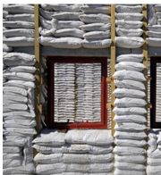
Fig.37_ Construção em sacos de areia. Cidade do Cabo, África do Sul.
