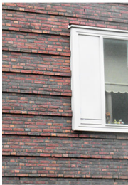
Fig.33_ Construção em tijolo maciço. Utrecht, Holanda.
