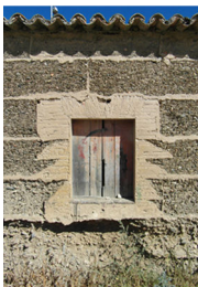
Fig.36_ Construção em taipa. Mértola, Portugal.
