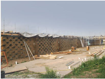
Fig. 104_ Parede-pneu em construção.
