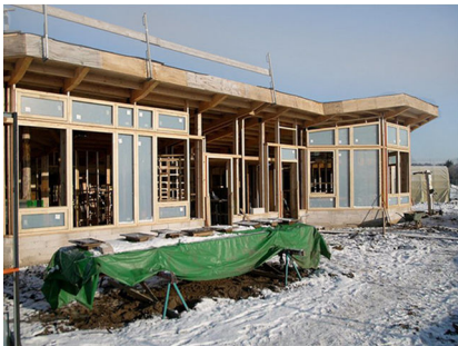
Fig. 105_ Fachada sul em construção.
