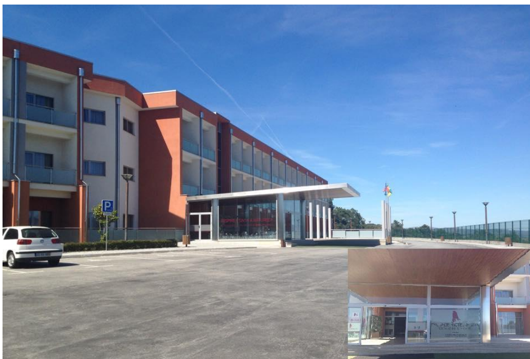
Figura nº VIII 40: Hotel Palace Hotel & SPA - Termas de S. Miguel (Parque da Serra da Esgalhada) Fonte: Autor (2015)
