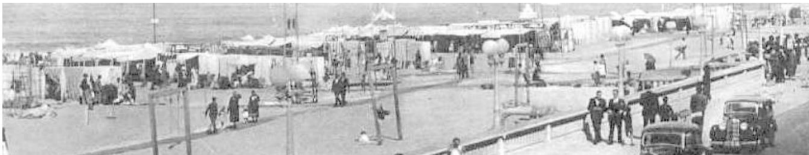
44| Frente marítima de Espinho nos anos 30 que demonstra a predominância de barracas de pano no areal.
