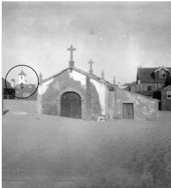
74 | Antiga Capela de Nossa Senhora dos Aflitos, com a Nova Capela ao fundo; fotografia da década de 40.
