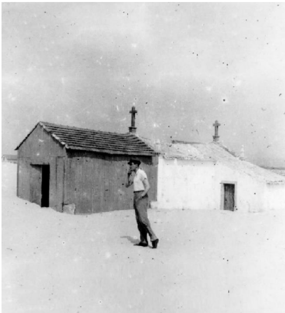
73 | Capela de Nossa Senhora dos Aflitos e da Boa Viagem em 1939.
