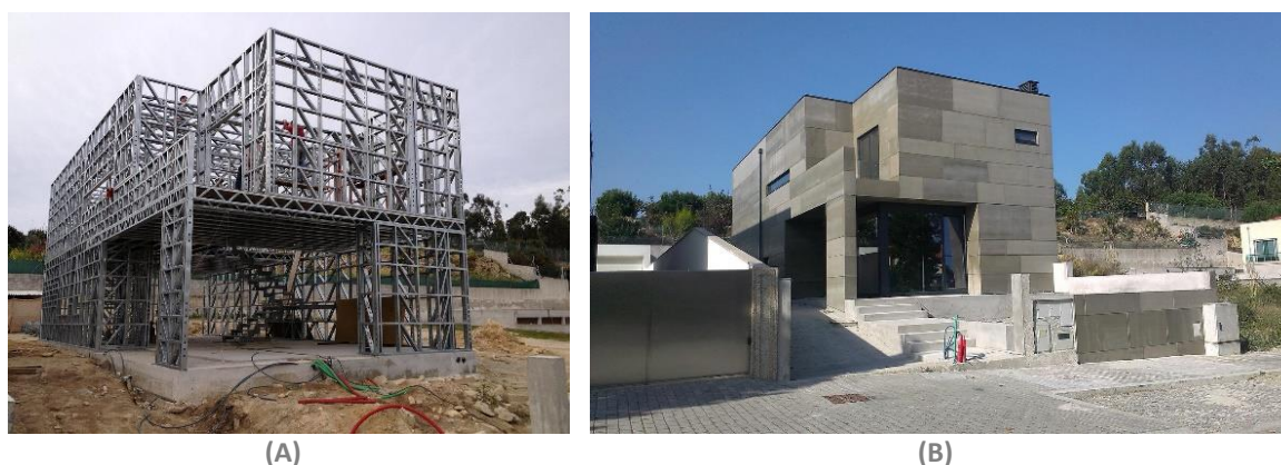
Figura 1.1 – Construção de habitação unifamiliar com estrutura LSF: (A) Fase de construção da estrutura metálica; (B) Fase final. Fonte: World Industrial Group.
