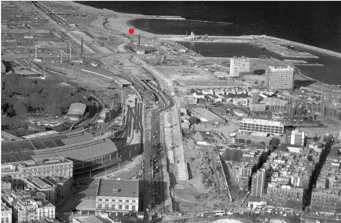
61. Vista aérea durante as construções de Paec del Mar
