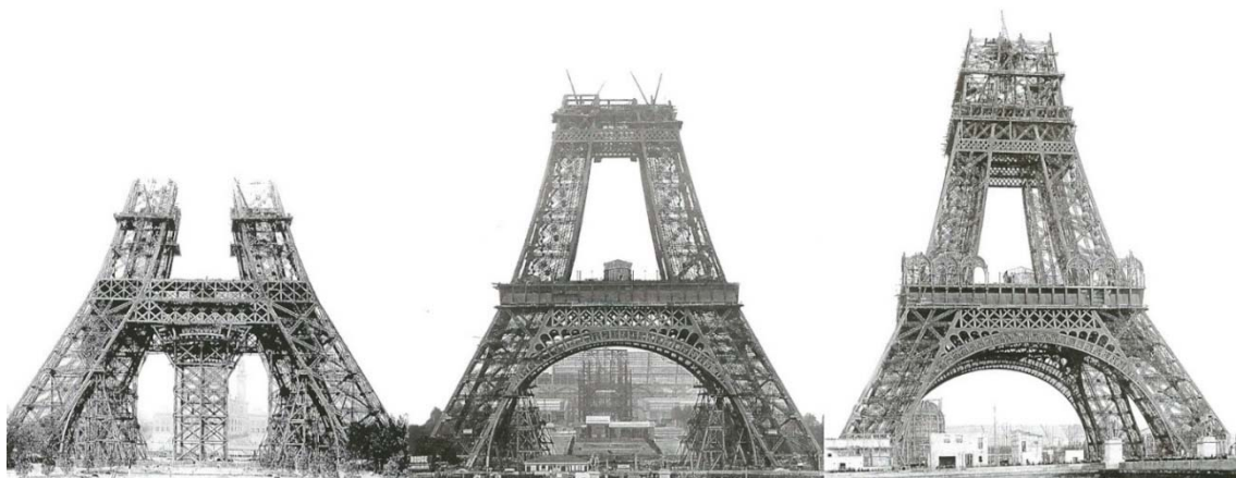
2. Torre Eiffel em construção
