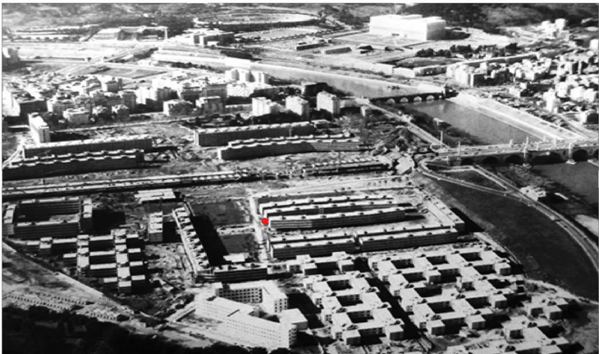
34 Foto Aérea Vila Olímpica em construção
