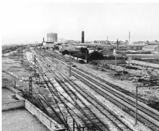
52. Vista sobre conjunto de vias de Ramal Marina
