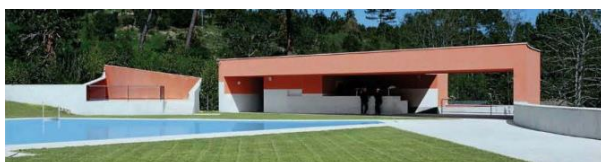
Figura 168. Bar de apoio à piscina exterior do estabelecimento termal
