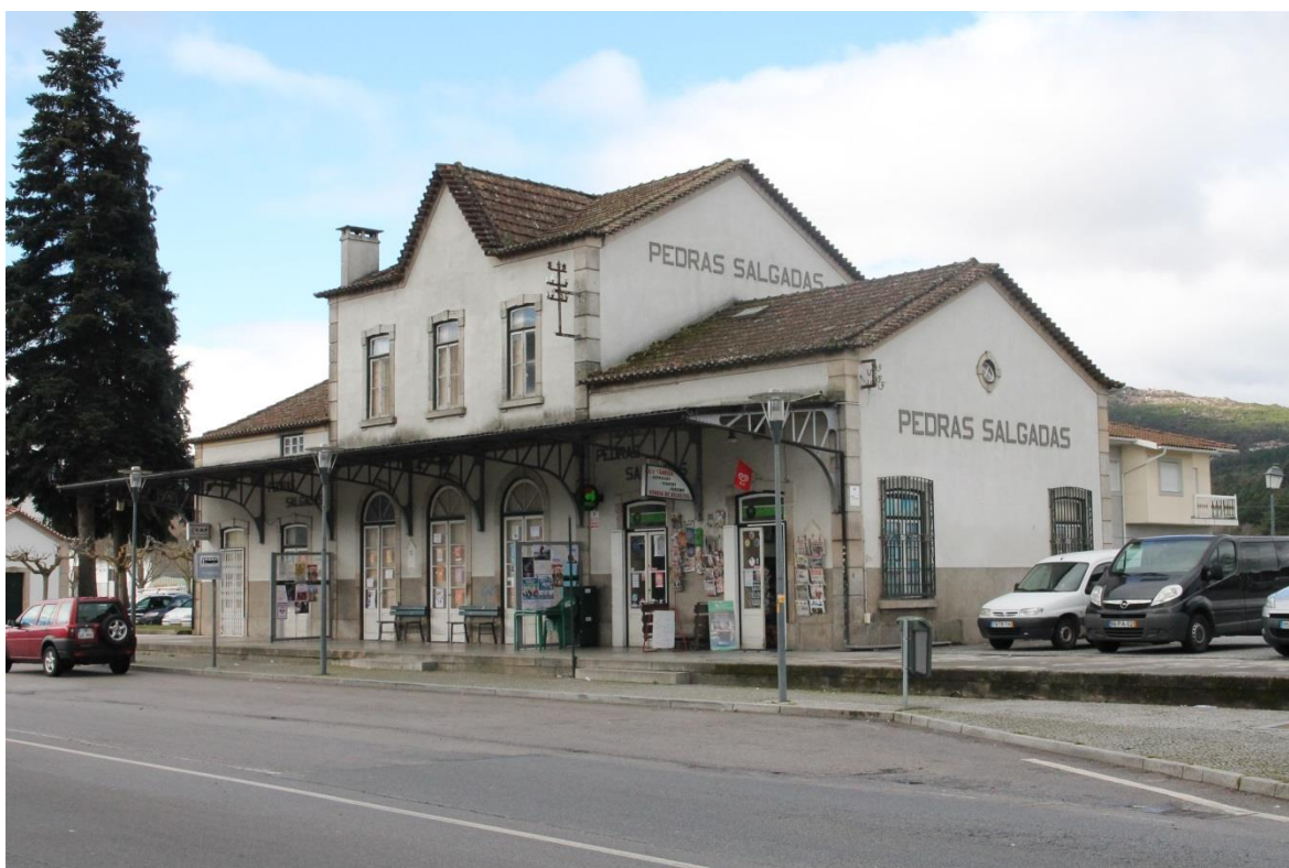
Figura 139. Edifício da estação transformado em central de autocarros
