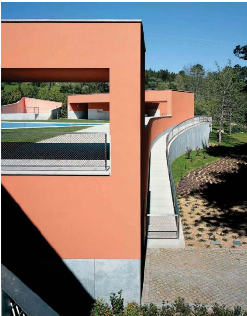
Figura 186. Rampa do estabelecimento termal
