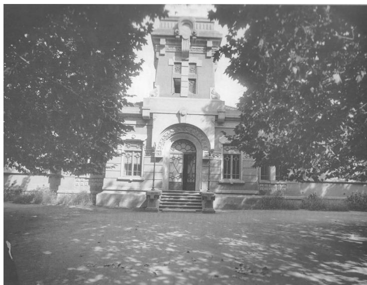
Figura 71. Termas do Vidago, fachada do estabelecimento termal
