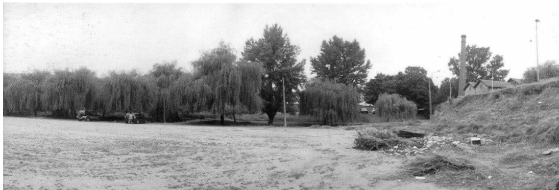
Fig. 58 Local de implantação do Forum antes da sua construção. Hélder Ferreira, 2002.
