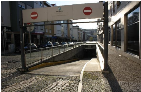
Fig. 69 R. D. José da Cruz Moreira Pinto – Acessos ao parque de estacionamento subterrâneo. Suse Almeida, 2014.
