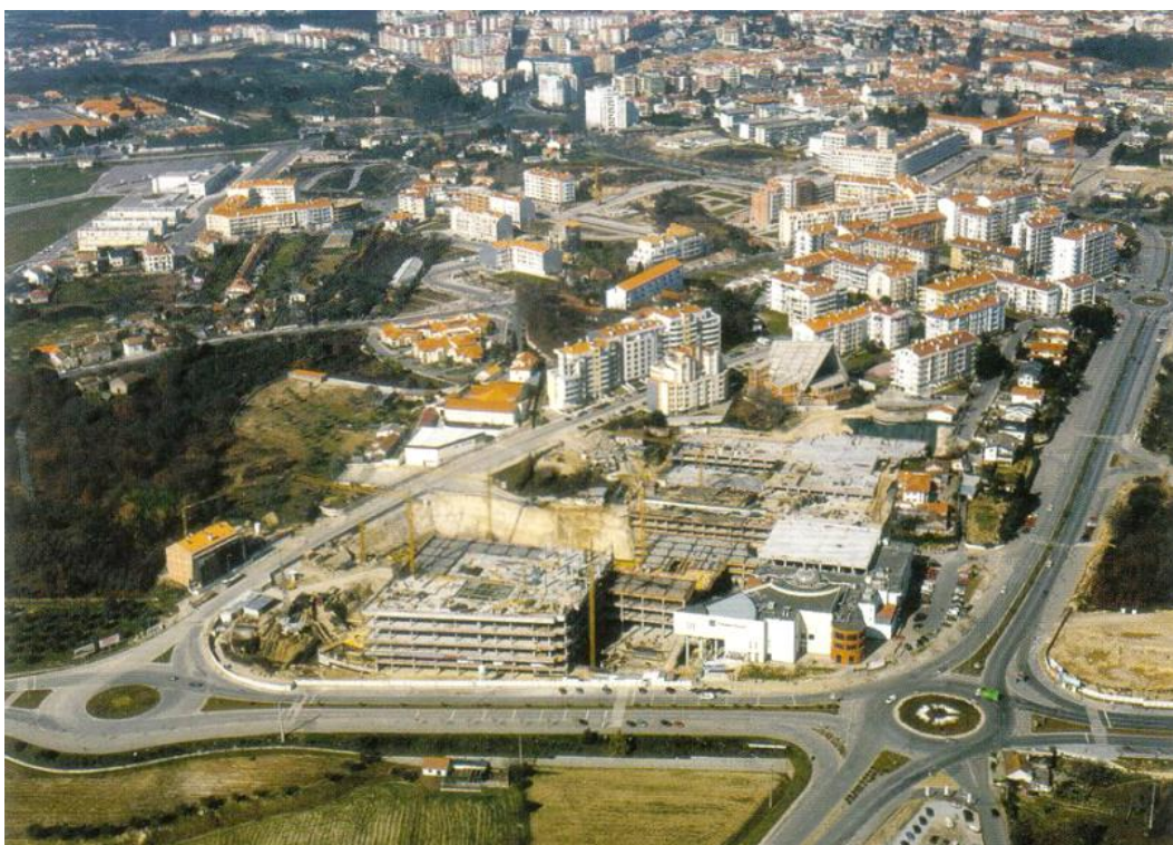
Fig. 47 Vista aérea sobre o empreendimento lúdico. Parte do novo edifício já em fase de construção. À direita ainda parte do antigo Palácio do Gelo. Fotografia de autor anónimo, 2006.
